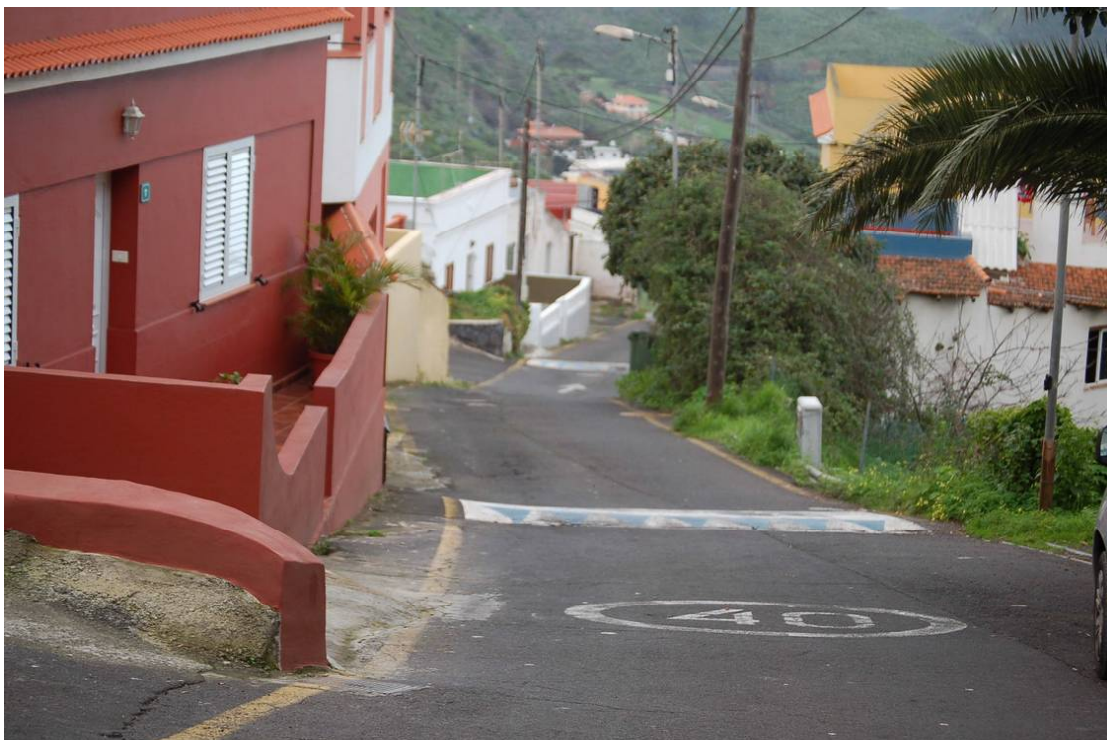
Ausencia de banda de servidumbre y protección de fachadas. El Portezuelo
