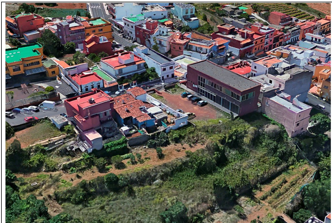
Determinación afectada nº 1. Imagen del estado actual del ámbito afectado
