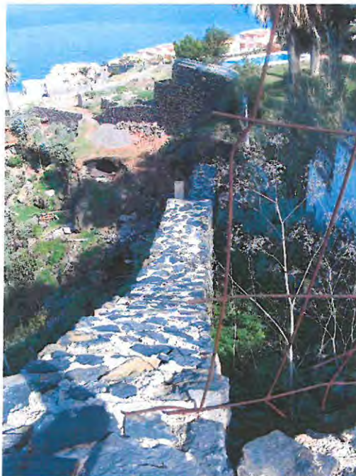
Tramo del camino litoral en la urbanización "La Mancha" que es necesario completar.
