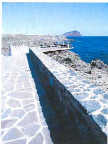
Pavimento de laja de piedra natural y murete de mampostería basáltica de molinera, combinado con zonas puntuales de madera, a ejecutar en el camino cercano a la urbanización de La Quinta Roja.
