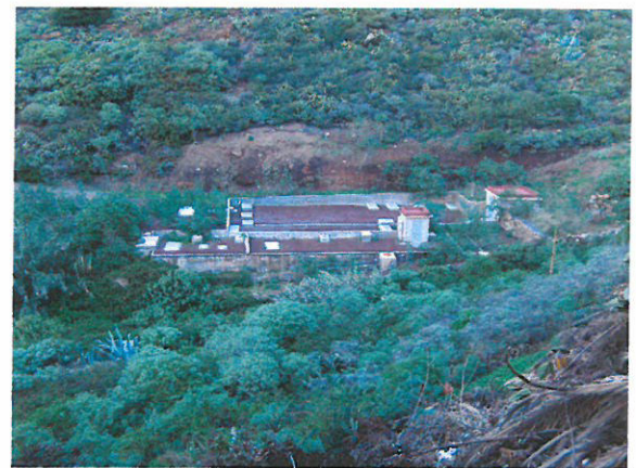
Estado actual de la depuradora de "La Quinta", de reciente ampliación.
