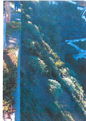
Vista desde el muro de la finca del talud y espacio para insertar el sendero en el tramo próximo a "Michel".
