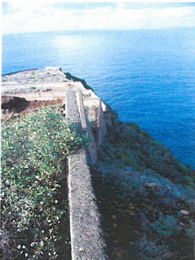
Terrenos de cultivos abandonadas y situadas al borde del acantilado, que se han transformado en suelo urbanizable, ámbito "La Quinta Roja".
