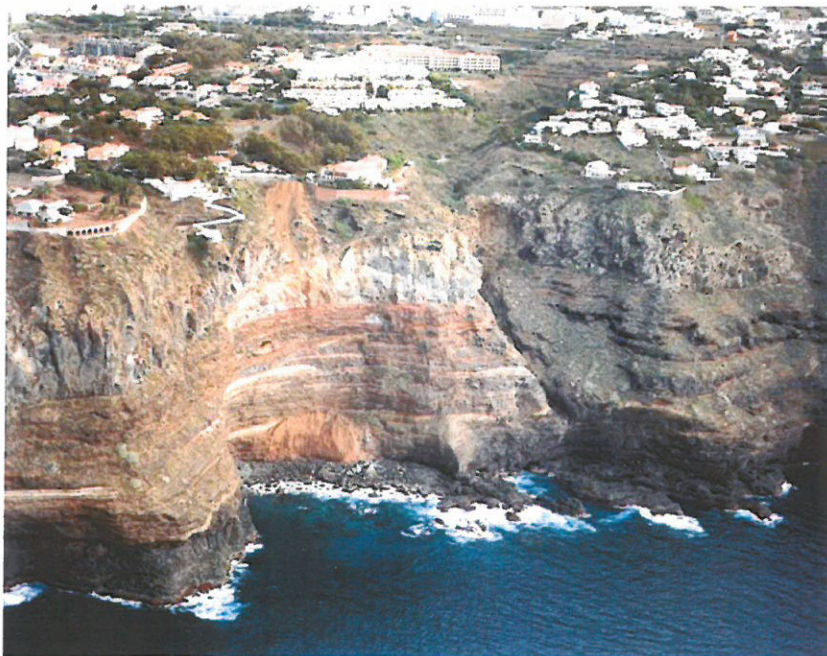
Foto característica del litoral de Santa Úrsula, costa acantilada de gran altura y belleza paisajística, coronada en tramos con edificaciones situadas en el borde de acantilado (Tramo de Michel)
