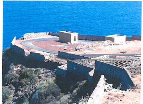
Aspecto actual de la depuradora en la zona del mirador "La Rapadura", con casetas de pretratamiento y reutilización vistas, y tratamiento Biológico y depósitos enterrados.
