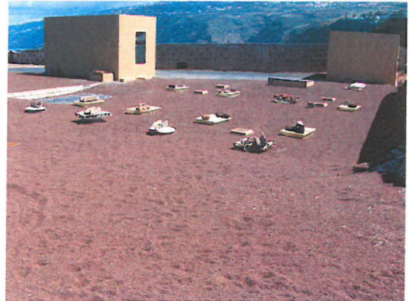
Foto de la caseta de reutilización en la zona próxima al mirador (impacto visual), infraestructura sin recinto vallado y arquetas de depuradora sin el cierre adecuado.
