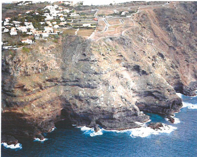
Vista del acantilado, barrio de Lomo Román, Urbanización en ejecución de la Mancha y sendero de acceso a Charco Negro.
