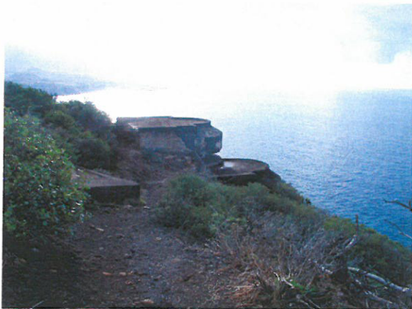
Foto del buen estado del bunker militar, 11ª batería la Quinta Roja, desde donde se divisa la costa norte de Tenerife.
