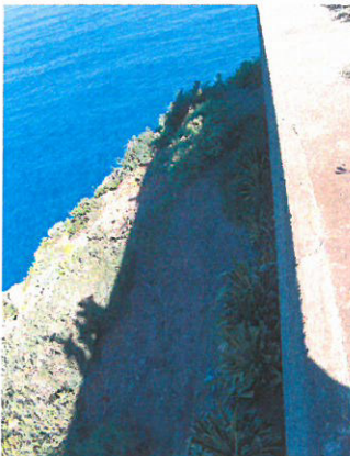
Vista desde el muro de la finca de otros tramos con menor dificultad. En él se aprecia el material suelto de la coronación del acantilado y la fuerte pendiente existente.
