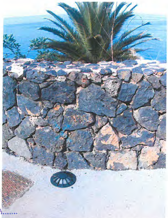
Foto de la iluminación rasante de este tramo actualmente existente del camino litoral. (La Mancha).
