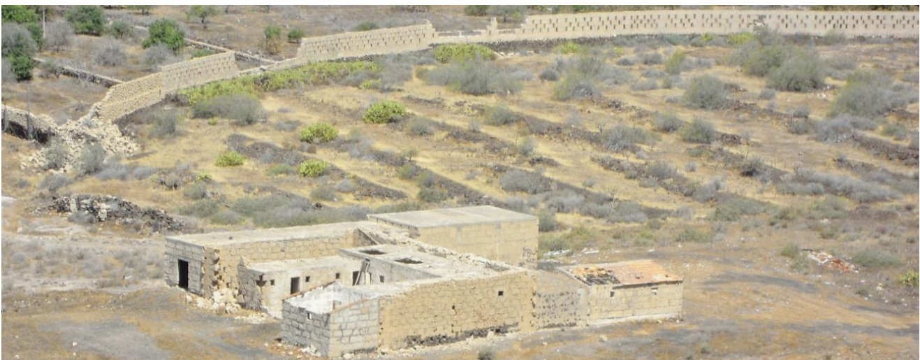
Imagen: Antiguas instalaciones agrícolas con sucesivas ampliaciones. Al fondo, cultivos de abandono prolongado, próximo a Montaña Negra. Elaboración propia.
