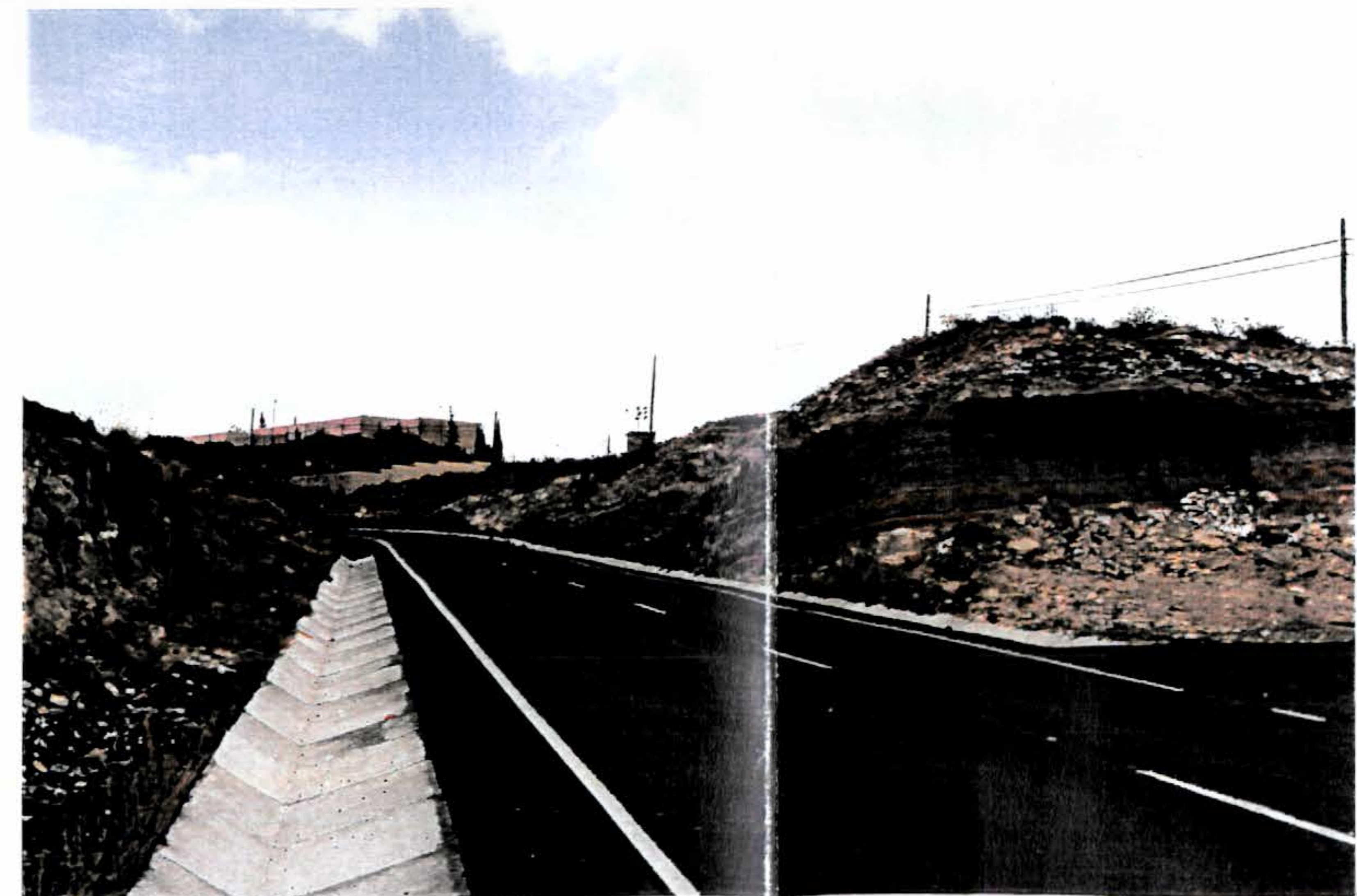
3 Vista desde la carretera general
