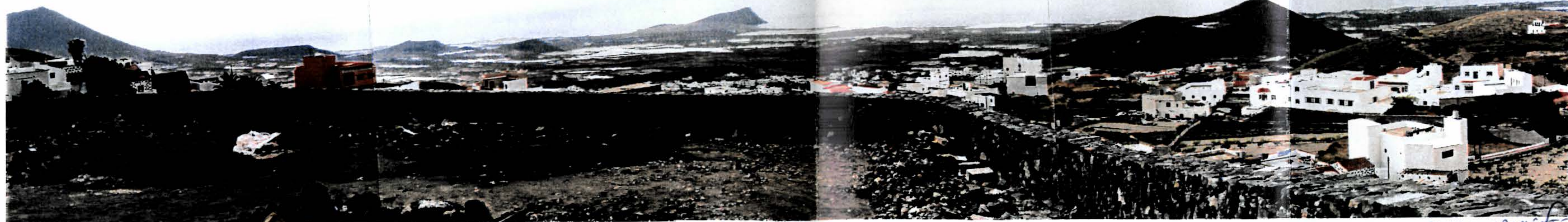
4 Vista del muro del mirador.
