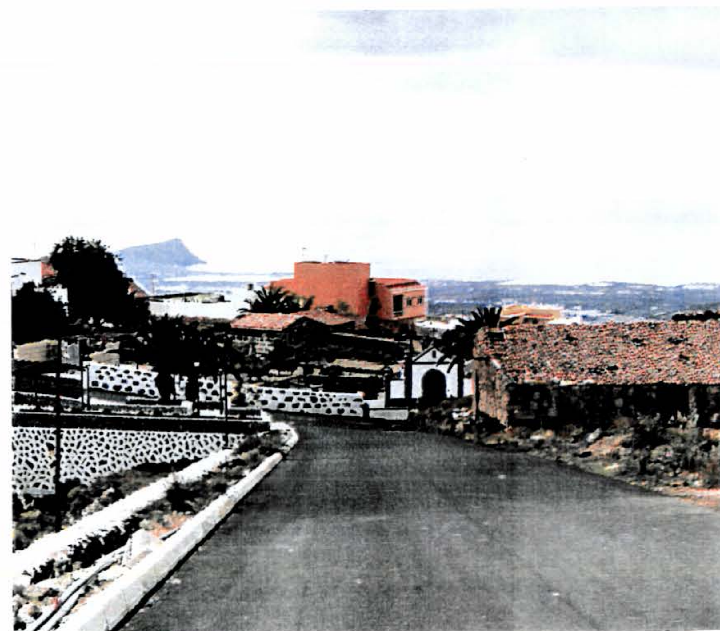
2 Vista de la calle recientemente urbanizada
