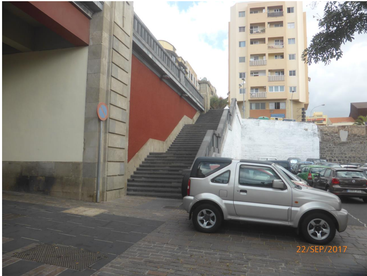
Ilustración 7: Escalera de acceso, al Puente Serrador, catalogada.
