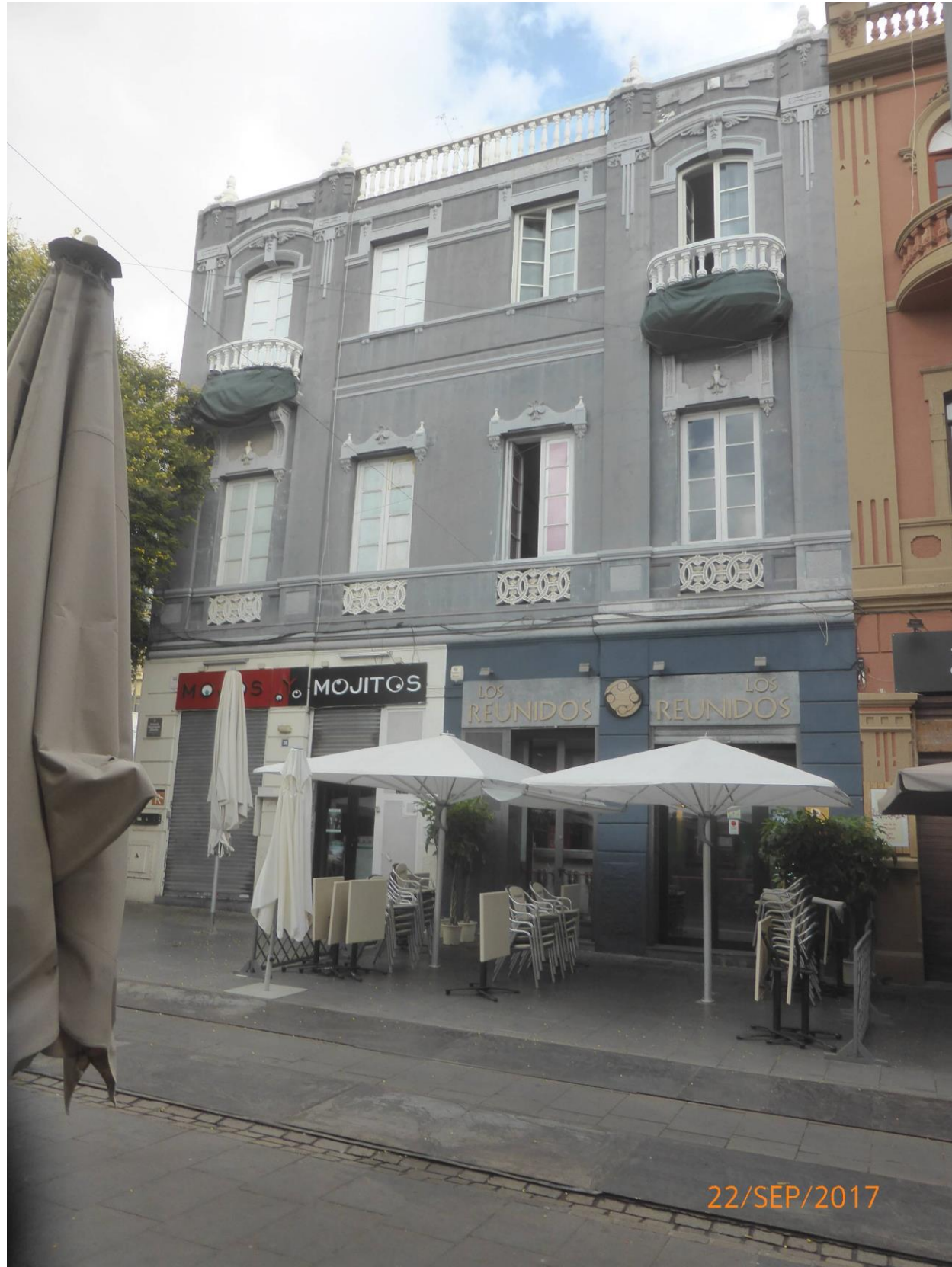
Ilustración 5: Edificación catalogada, adyacente a la parcela de estudio, calle Antonio Domínguez Alfonso
