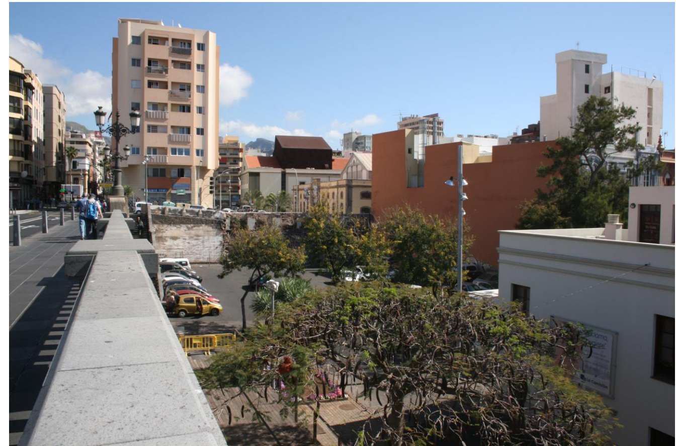
Ilustración 20: Vista desde el Puente Serrador hacia la parcela de estudio.
