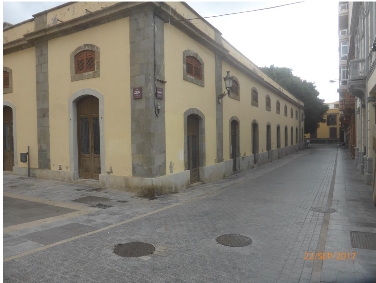
Ilustración 13: Calle Miraflores, aguas abajo.
