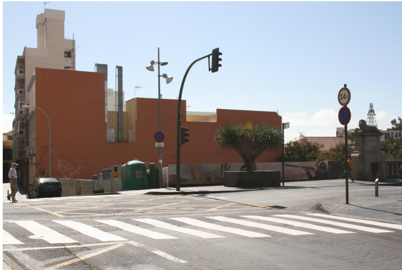
Ilustración 19: Skyline de la Medianera de las Edificaciones adyacentes, catalogadas
