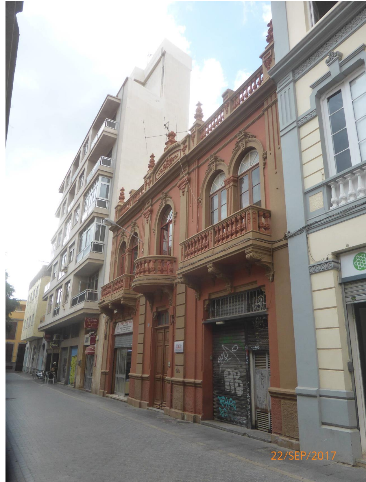
Ilustración 16: Edificación catalogada, próxima a la parcela de estudio, calle Miraflores.
