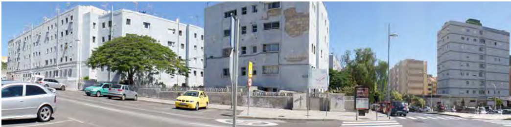
Imagen: Grupo de 115 Viviendas Nº Señora de La Candelaria. Bloques A y B.
