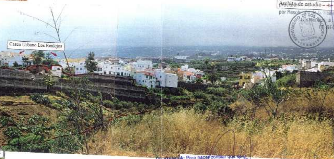
FOTO 2: Vista del límite Oeste del Plan Parcial junto al Bco. de Palo Blanco. Podemos ver que se trata de la zona de mayor pendiente del sector y se corresponde con la manzana n°10, zona libre, que será acondicionada, en su límite con el viario y las edificaciones, plantando árboles cada 6m; esta zona libre actúa como zona de transición entre el uso residencial y el suelo rústico exterior (Bco. de Palo Blanco). El resto de la zona libre se acondicionará con especies de menor porte como Euphorbia canariensis , Rumex lunaria , Argemone frutescens , etc. Las paredes hormigonadas, que se encuentran sobre los bancos, serán demolidas y retiradas a vertedero. En el borde inferior izquierdo de la foto se pueden ver los muros de los bancos rotos; esto está provocando la erosión y la pérdida de suelos. Esta zona es de incidencia visual alta, tanto para los usuarios de la C-820, como para los de la C/La Constitución.
