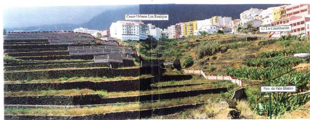
FOTO 3: Vista panorámica del límite Norte del Plan Parcial, que corresponde a la zona más baja. Se pueden ver los bancales, el suelo vegetal que lo ocupa y los muros de hormigón que serán trasladados al vertedero después de su demolición. También observamos el cauce del Bco. de Palo Blanco, justo en la zona cercana a la carretera C-820, donde forma una depresión, después de instalar una canalización correctamente dimensionada que conectará con la obra de fábrica de esta carretera para encauzar este tramo de barranco, será rellenada con material inerte y sobre ella se instalará el viario que conecte la C/ La Constitución con la C/ La Palmita al Este, además de una amplia zona verde que servirá de transición entre la C-820 y la parcela urbanizada. Por otro lado, en dicho tramo de barranco se avistan algunos bancales en los que aparecen cultivos de platanera, vestigios del uso agrícola pasado. Por último, podemos apreciar cómo a la derecha aparece una edificación agrícola abandonada, que será demolida y trasladada a un vertedero.
