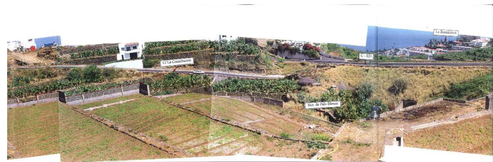
FOTO 3: Vista panorámica del límite Norte del Plan Parcial, que corresponde a la zona más baja. Se pueden ver los bancales, el suelo vegetal que lo ocupa y los muros de hormigón que serán trasladados al vertedero después de su demolición. También observamos el cauce del Bco. de Palo Blanco, justo en la zona cercana a la carretera C-820, donde forma una depresión, después de instalar una canalización correctamente dimensionada que conectará con la obra de fábrica de esta carretera para encauzar este tramo de barranco, será rellenada con material inerte y sobre ella se instalará el viario que conecte la C/ La Constitución con la C/ La Palmita al Este, además de una amplia zona verde que servirá de transición entre la C-820 y la parcela urbanizada. Por otro lado, en dicho tramo de barranco se avistan algunos bancales en los que aparecen cultivos de platanera, vestigios del uso agrícola pasado. Por último, podemos apreciar cómo a la derecha aparece una edificación agrícola abandonada, que será demolida y trasladada a un vertedero.
