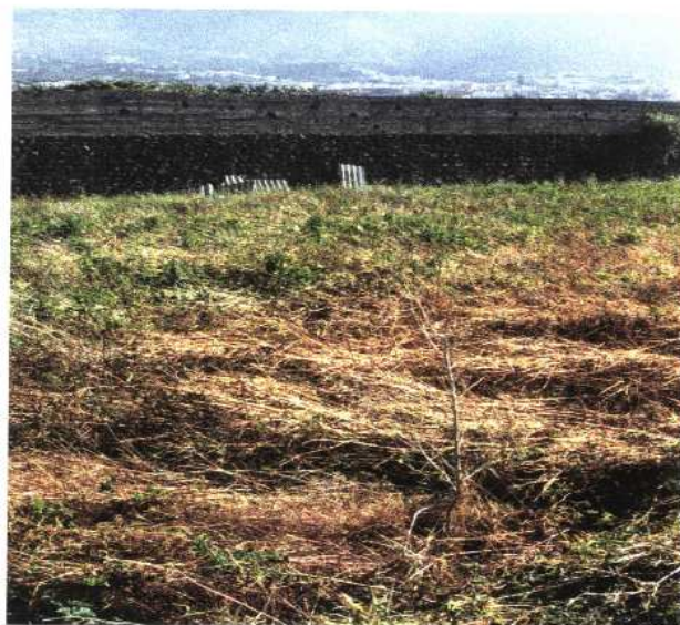
FOTO4: Vista de una de las parcelas abancaladas, en la cual podemos observar la vegetación de la zona, caracterizada por especies de afinidad nitrófila ruderal. Esta se instala en áreas que han sufrido el abandono de la actividad agrícola. En esta foto se observan los muros que constituyen los bancales. Estos están realizados en piedra natural sobre los cuales se han levantado paredes de hormigón. La piedra natural será reutilizada en la ejecución de este Plan Parcial para la realización de los muretes que se lleven a cabo en el ámbito. De otra parte los restos de las paredes de hormigón serán llevados a vertedero autorizado. De igual modo serán transportados a vertedero los residuos existentes en la zona tales como los que se encuentran apoyados en el muro (restos de uralla).
