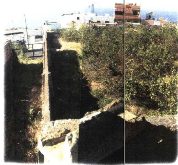
FOTO2: Vista del área del ámbito en la cual se puede observar una de las vías de tierra que llegan hasta la calle El Montarrio, se trata de una vía asfaltada que quedará incluida en la transformación urbana en la cual se engloba el ámbito. Estas vías se encuentran cerradas mediante cancela metálica. Se puede observar también una finca destinada al cultivo de limón que se encuentra en estado de semiabandono y los árboles que aún aparecen los árboles con su fruta. Estos serán desbrozados antes de comenzar la fase de obras y los restos serán llevados a vertedero donde recibirán un tratamiento adecuado, recomendándose la elaboración de compost con los mismos.
