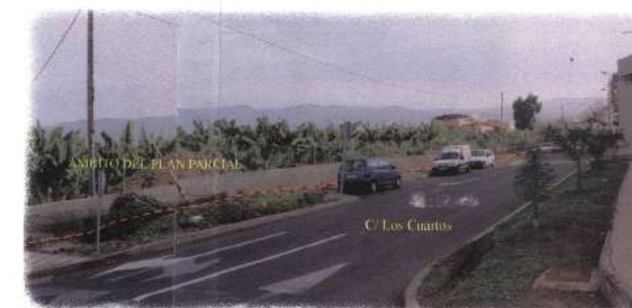
FOTO 2: Límite Oeste del Plan Parcial, calle Los Cuartos, donde se pueden ver los cultivos de plataneras en bancales, así como el muro de bloques prefabricados y la valla que serán demolidos y retirados a vertedero autorizado. En este punto se puede observar la situación de una caja de registro de telefónica desde donde se podrá suministrar este servicio a la urbanización a ubicar en la superficie de este Plan Parcial.
