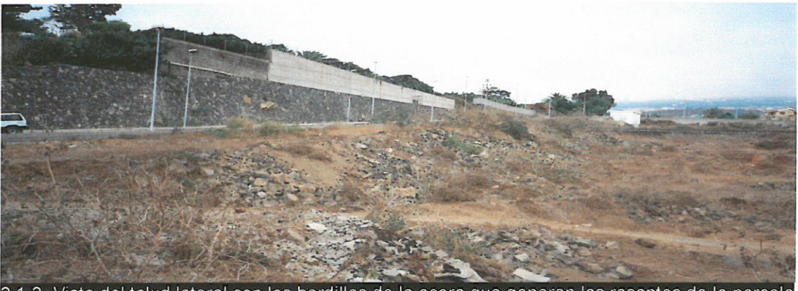
2.1.2. Vista del talud lateral con los bordillos de la acera que generan las rasantes de la parcela
