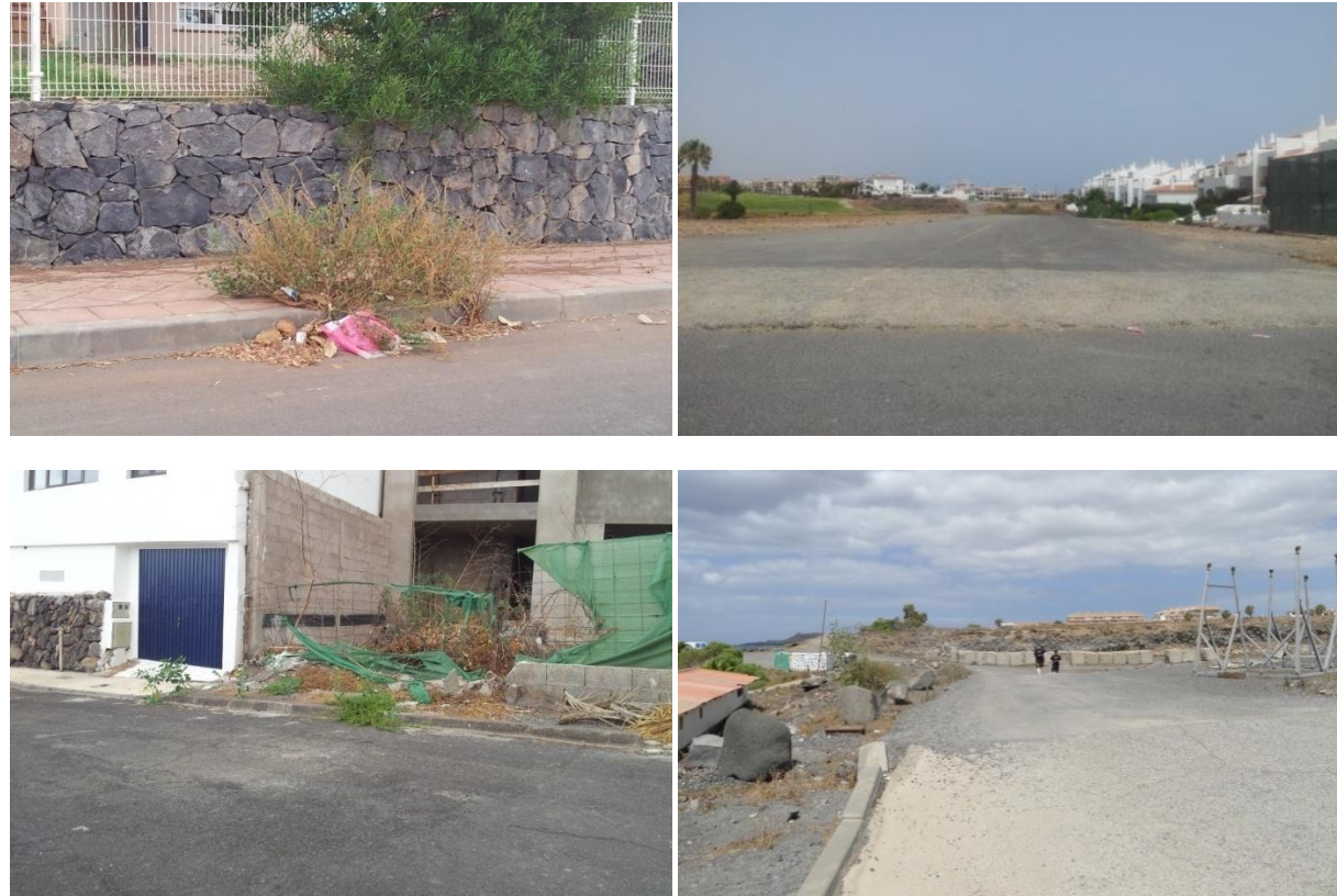
Imágenes: Aceras que no cumplen con la Ley de Accesibilidad. Elaboración propia
