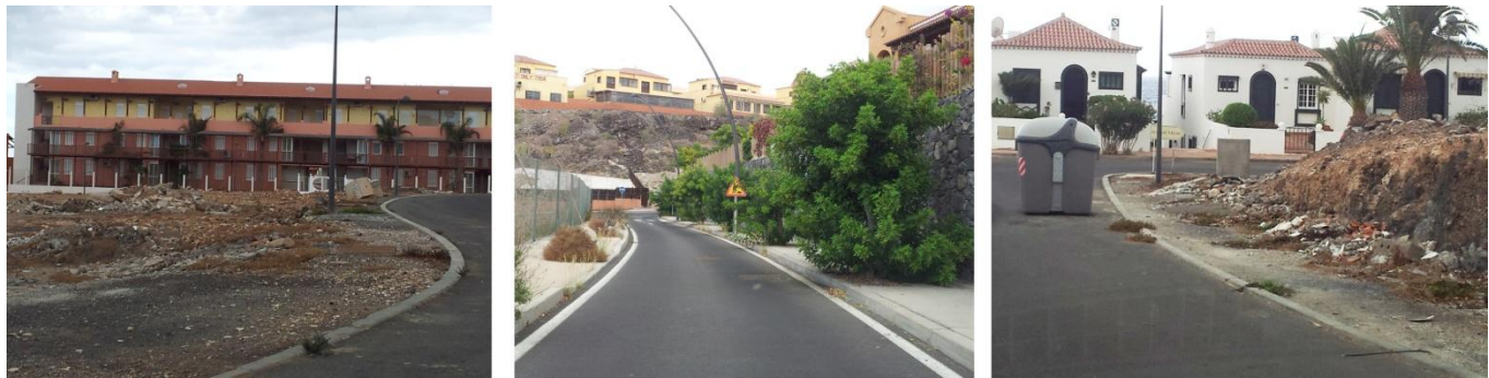
Imagen: Aceras y calzadas en mal estado de conservación. Elaboración propia.
