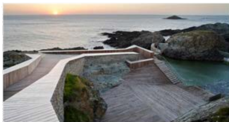
acceso piscina Tapia de Casariego
