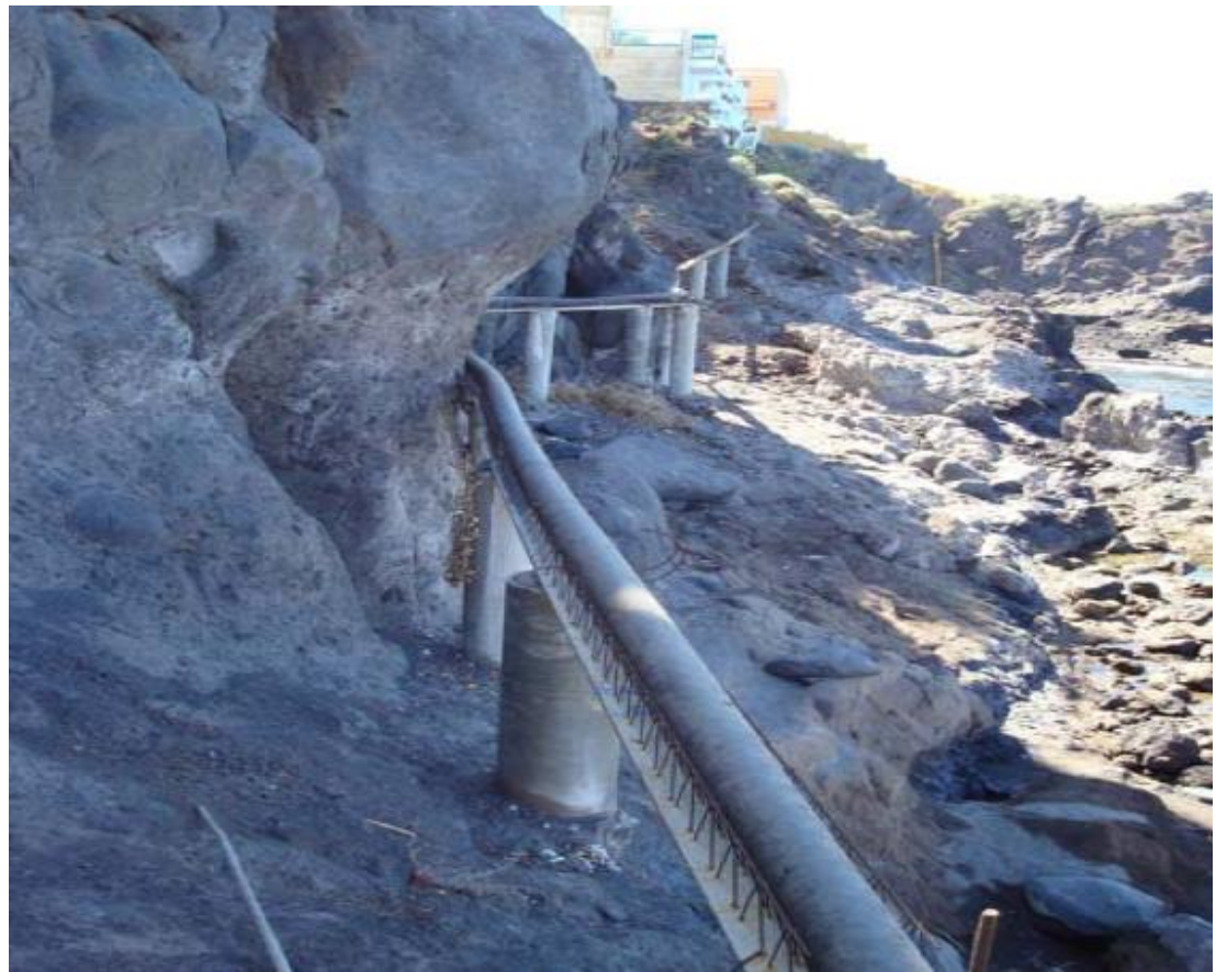
Imagen: Conducción de aguas hasta el Charco de los Chochos. Fuente: Propia.
