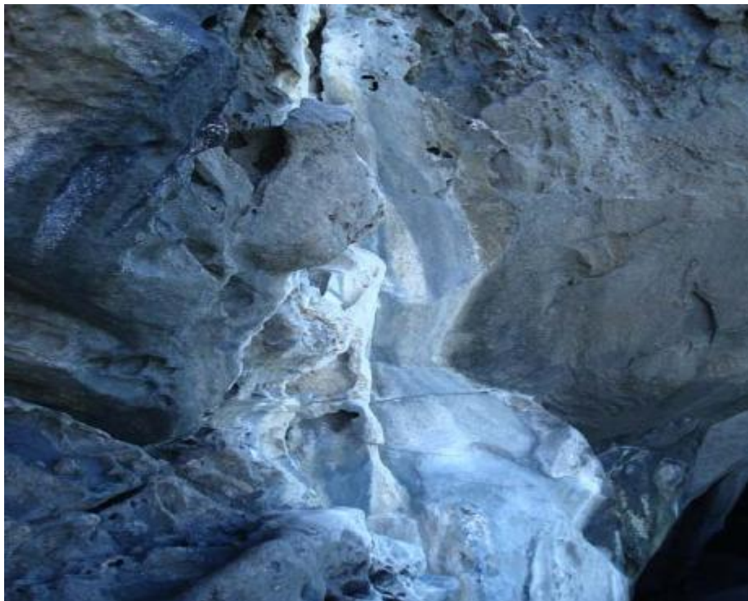
Imagen: Aliviadero bajo Apartamentos Europa. Fuente: Propia.
