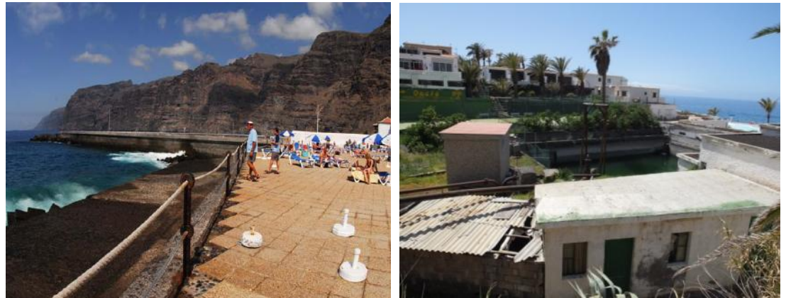
Imágenes del EBAR El Laguillo y el área de aliviadero.
