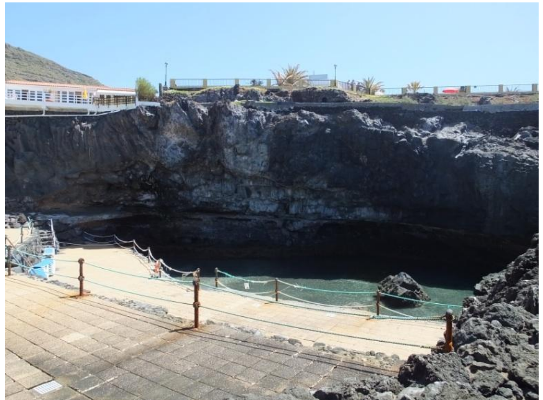
Imagen: Conducción de aguas residuales en la parte superior del acantilado. Fuente: Propia.
