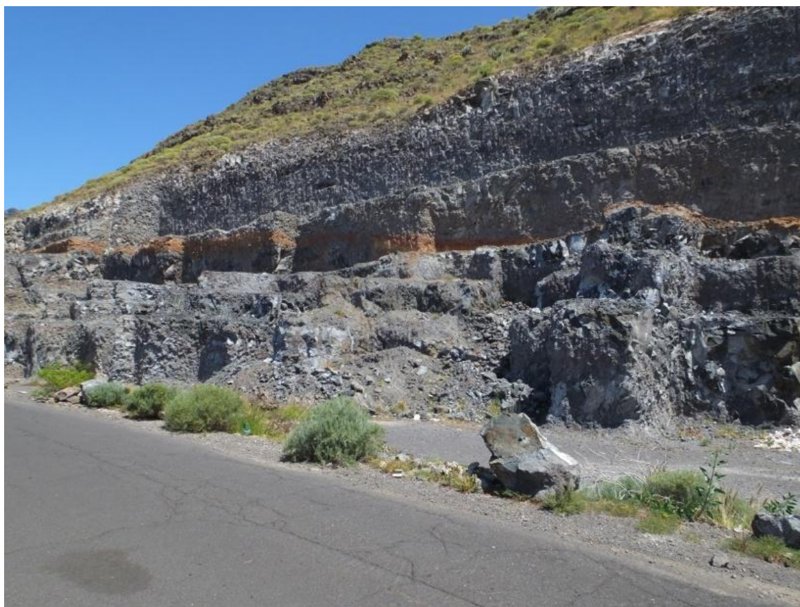
Imagen: Talud de origen antrópico, calle Geranio, Los Gigantes. Fuente: propia.
