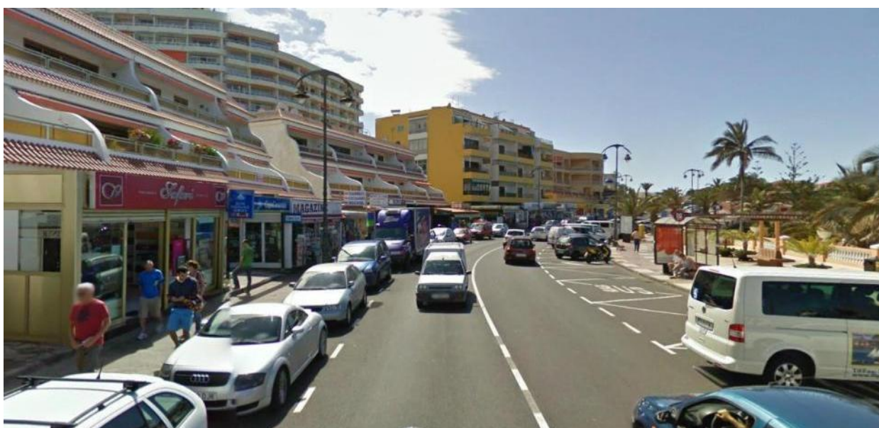
Imagen: Vista orientación sur. Fuente: Propia
