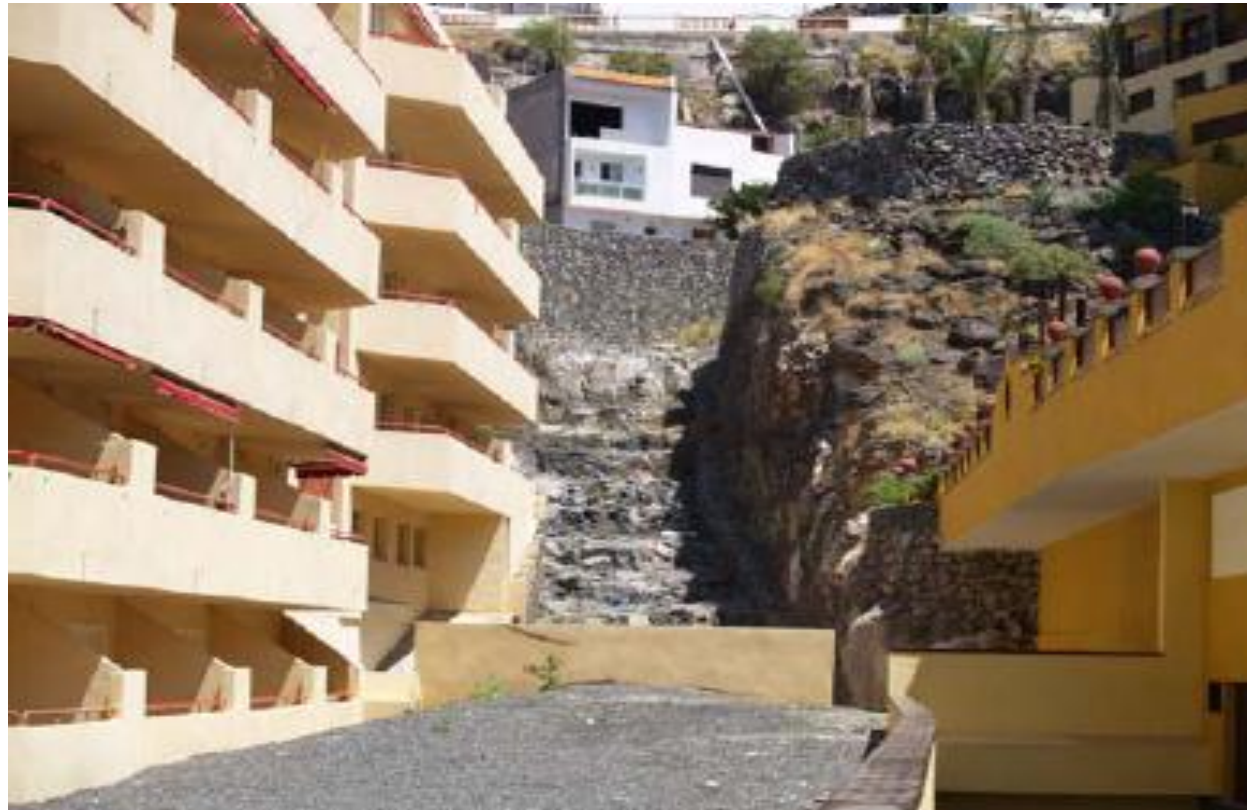
Imagen: Encauzamiento a cielo abierto del barranco de Santiago a su paso por Puerto Santiago. Fuente: Propia
