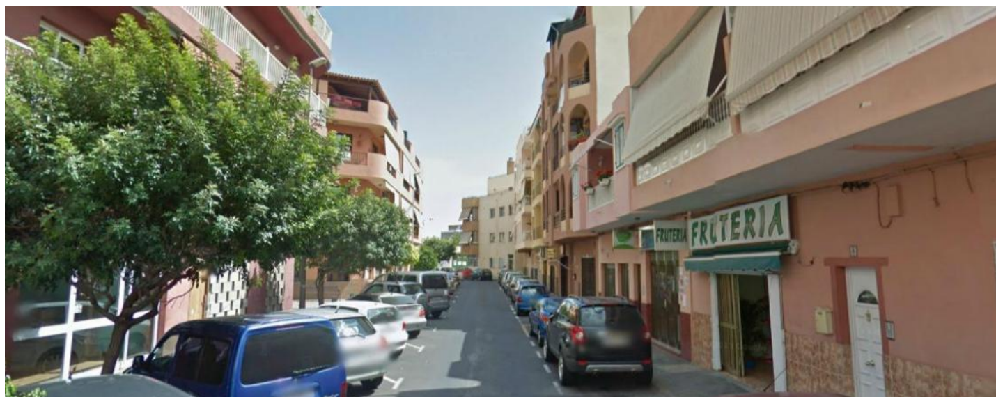
Imagen: Elementos sobresalientes en fachadas. Calle Herrador
