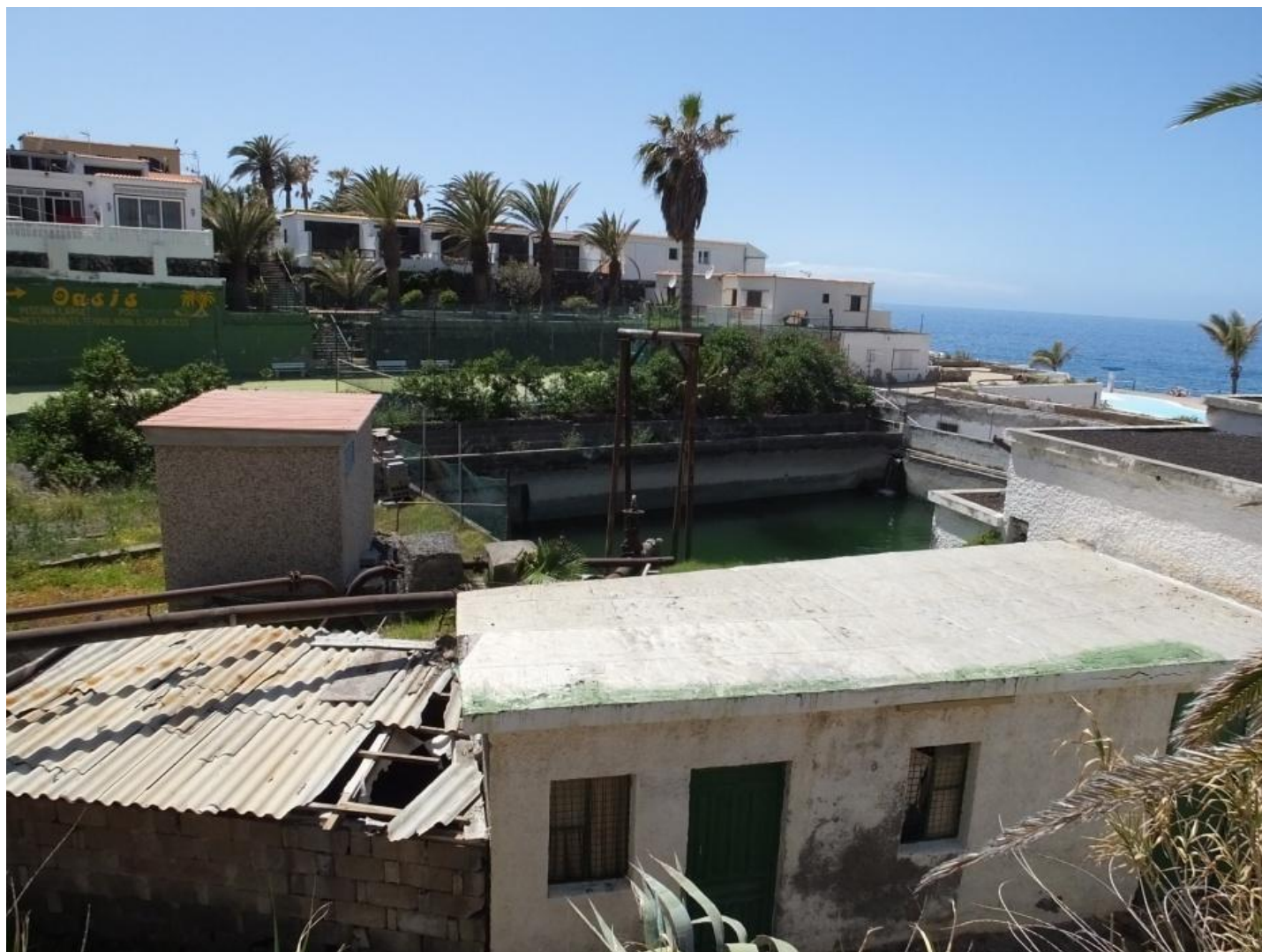
Imagen: Estación de Tratamiento de Aguas Residuales (ETAR) y la Estación de Bombeo de Aguas Residuales (EBAR) de El Laguillo, Los Gigantes. Fuente: Propia
