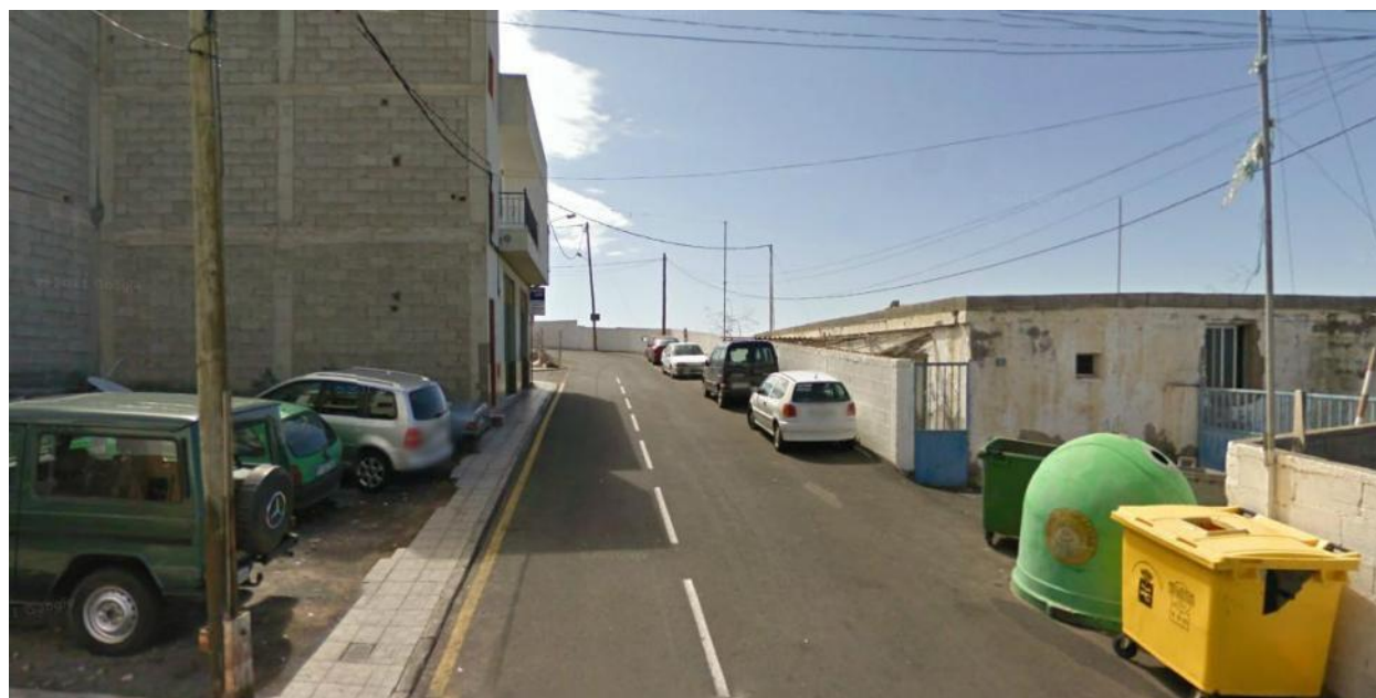
Imagen: Vista orientación sur. Fuente: Propia.
