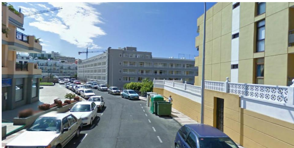
Imagen: Vista orientación sur. Fuente: Propia
