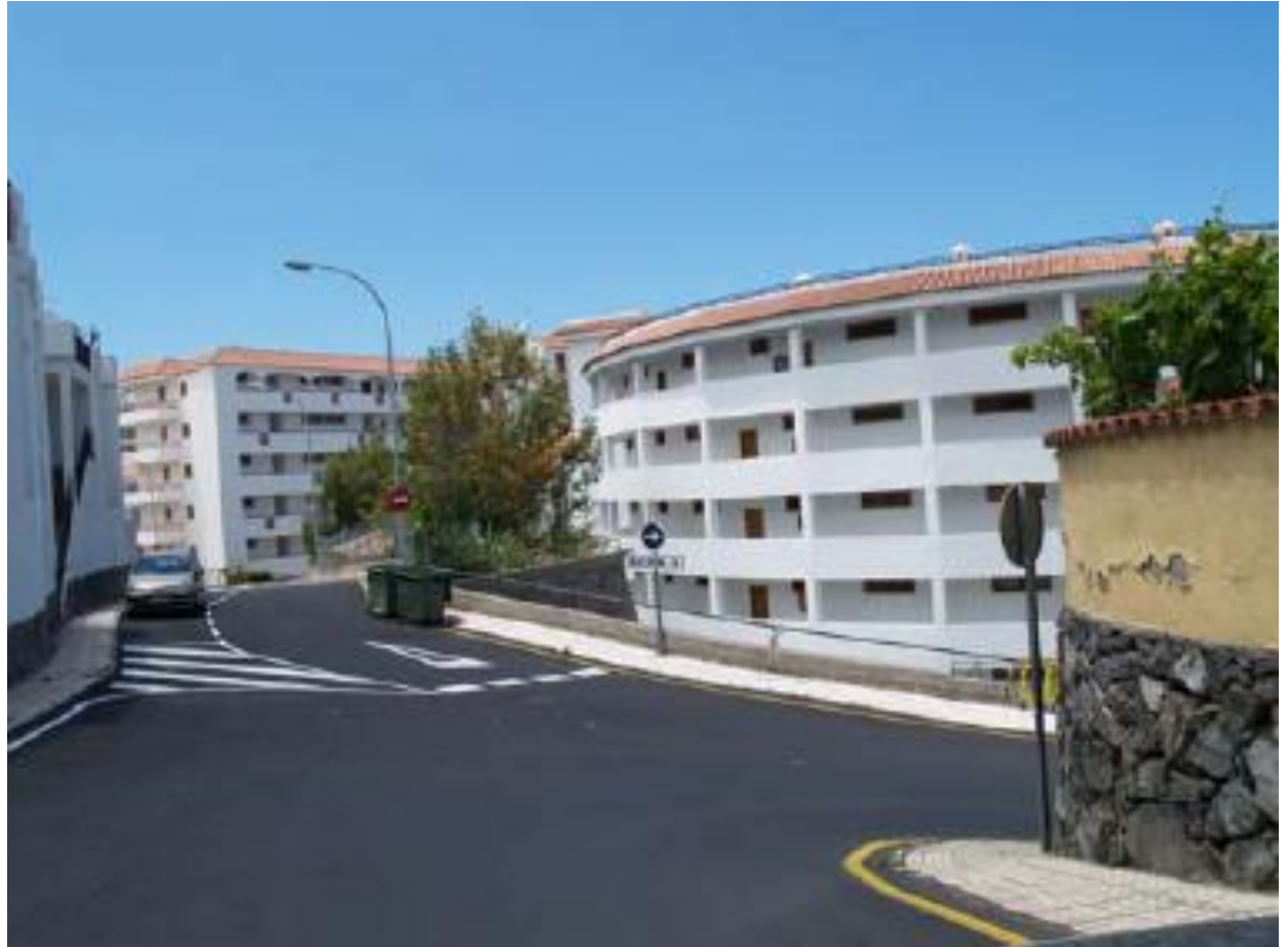
Imagen: Encauzamiento del barranco del Llano de los Salvajes a su paso por Playa de La Arena. Fuente: Propia
