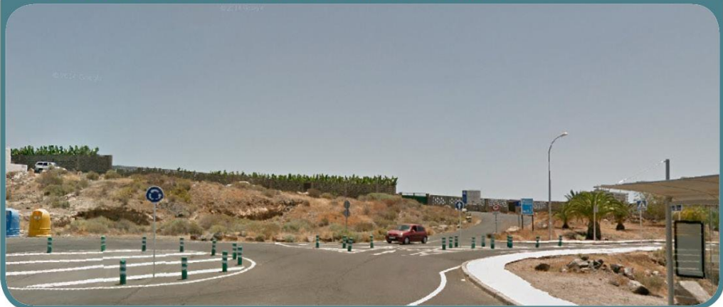
FOTO DEL ESTADO ACTUAL DE LA INTERVENCIÓN
