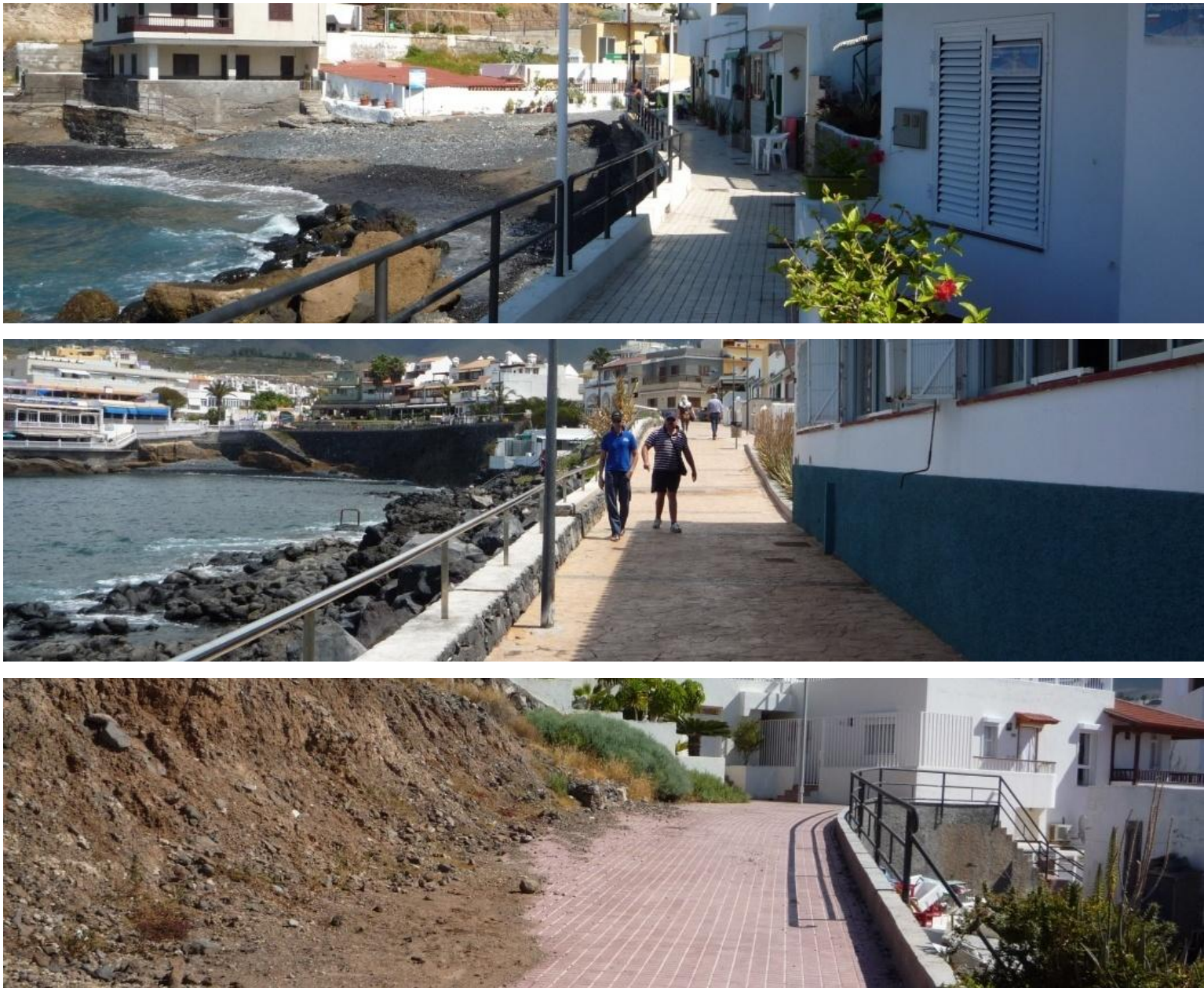
Foto: Sendas peatonales. La Caleta. Fuente: Propia
