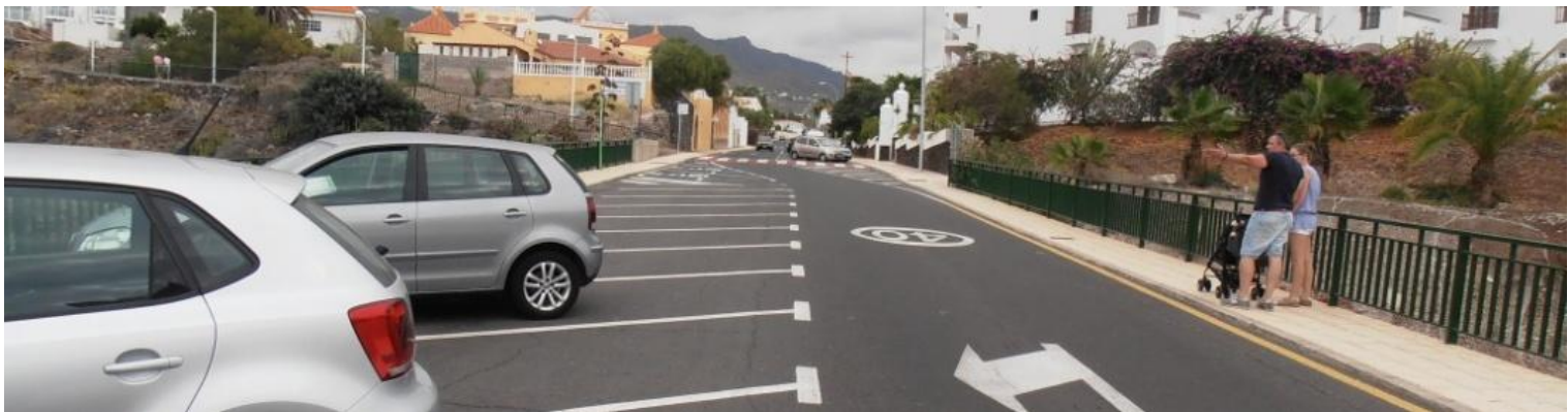
Foto: Aceras con ancho libre inferior 1,80 metros. Fuente: Propia
