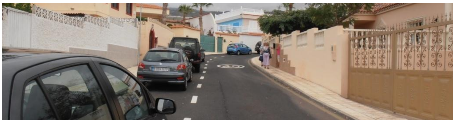
Foto: Aceras con ancho inferior a 1.40m. Calle El Callao. Fuente: Propia
