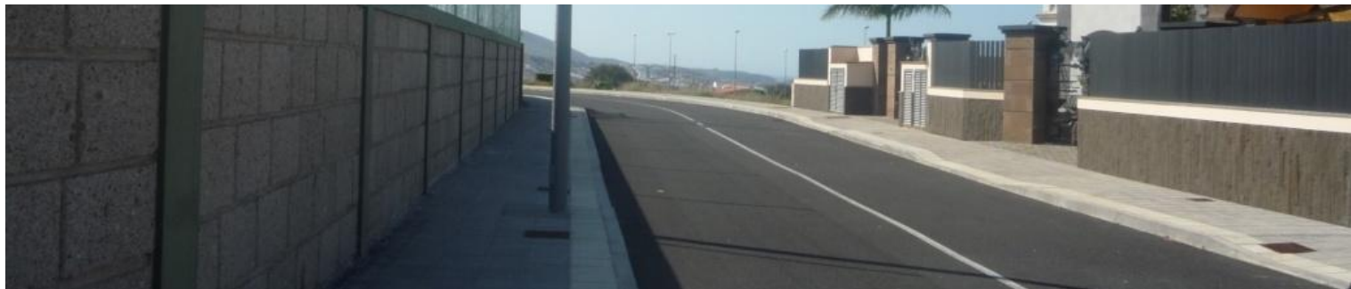
Foto: Aceras con ancho libre inferior a 1,80 m. La Caleta. Fuente: Propia
