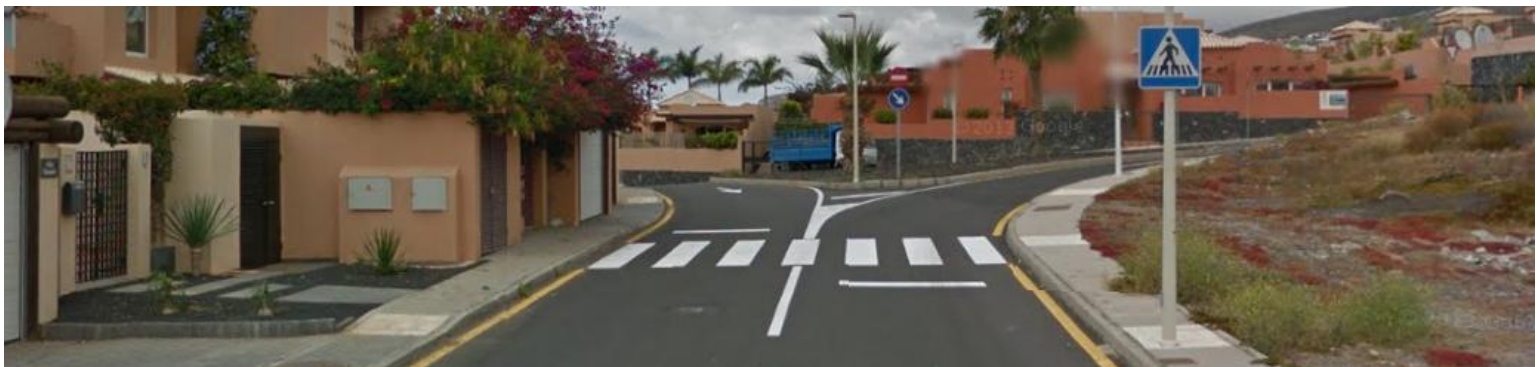
Foto: Paso de peatón no adaptado. Fuente: Propia
