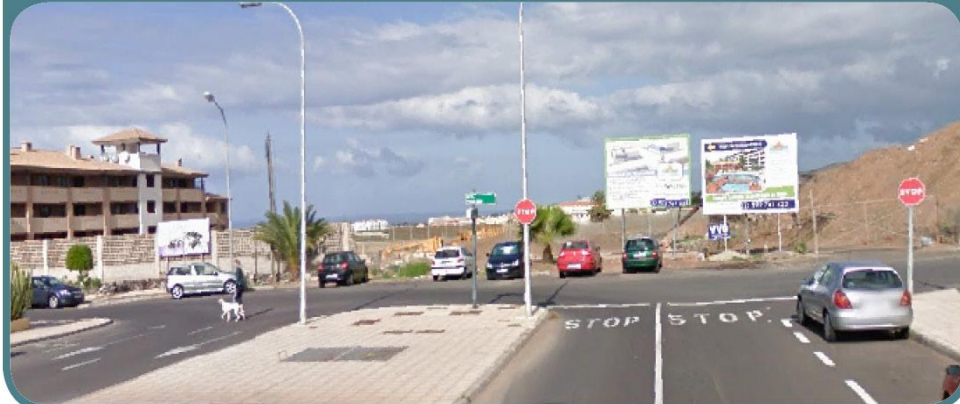
FOTO DEL ESTADO ACTUAL DE LA INTERVENCIÓN
