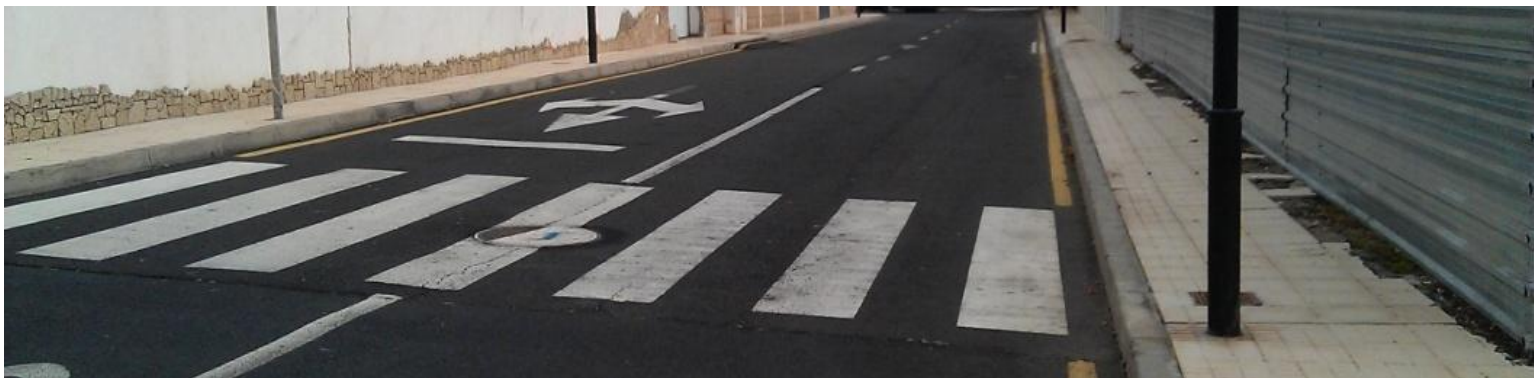
Foto: Aceras con ancho libre inferior 1,80 metros. Fuente: Propia
