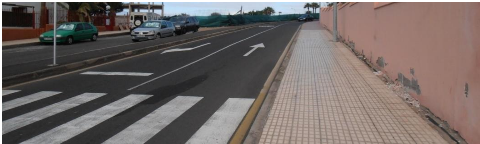
Foto: Aceras ancho superior a 1,80. Calle La Galga. Fuente: Propia
