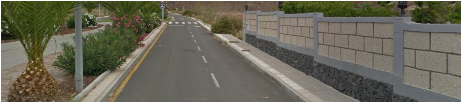
Foto: Aceras con ancho libre inferior 1,80 metros. Fuente: Propia
