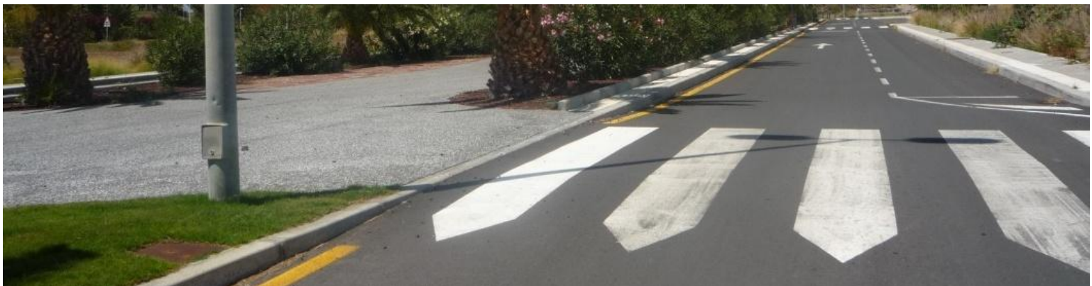
Foto: Paso de peatón adaptado no rebajado sin banda señalizadora. Fuente: Propia
