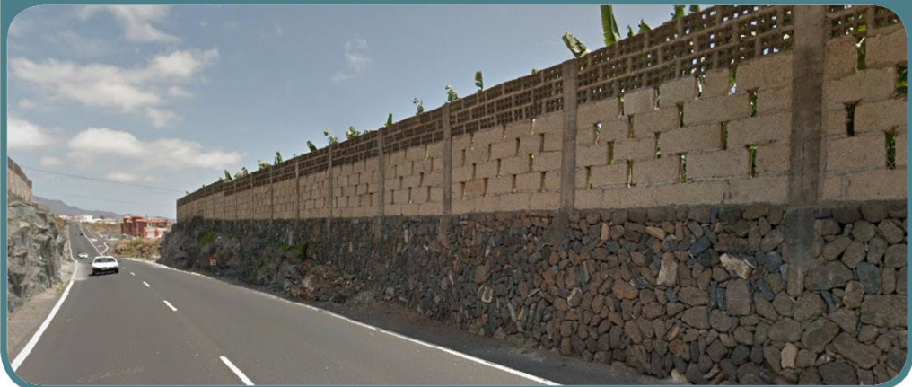
FOTO DEL ESTADO ACTUAL DE LA INTERVENCIÓN
