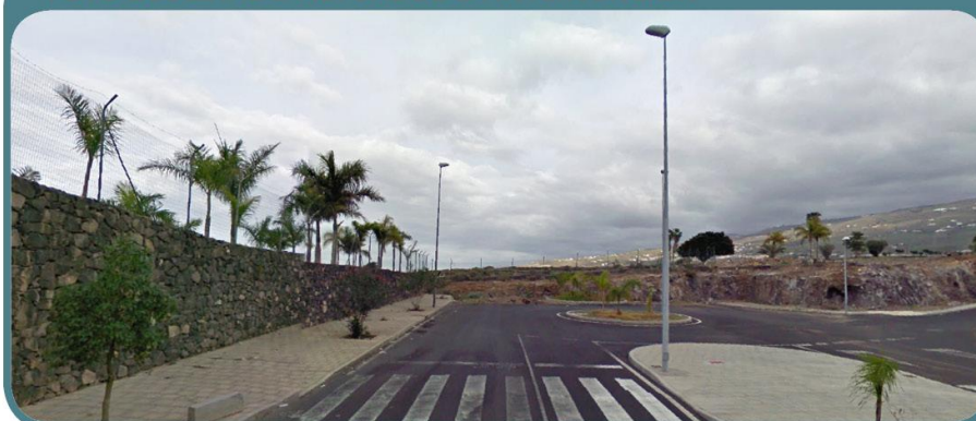
FOTO DEL ESTADO ACTUAL DE LA INTERVENCIÓN
