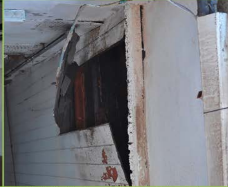
CERRAMIENTOS. Alta heterogeneidad en cartelería, sin imagen de marca unitaria y efectiva, mal estado de conservación de los carteles.
