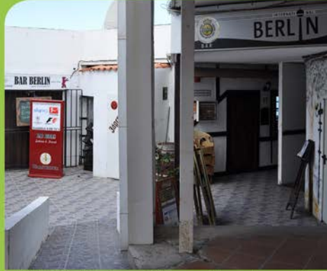
ESTRUCTURA. Estructura metálica con problemas de corrosión por alta exposición a ambiente marino y falta de mantenimiento.
