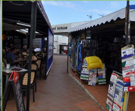
TRANSITABILIDAD INTERIOR. Invasión de espacios comunes por pérgolas que dificultan y ocultan el acceso a los locales interiores.
