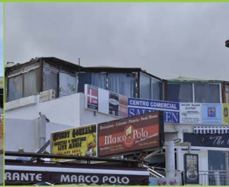
ACABADOS. Autoconstrucciones en cubierta de muy baja calidad constructiva y estética en la fachada marítima.
