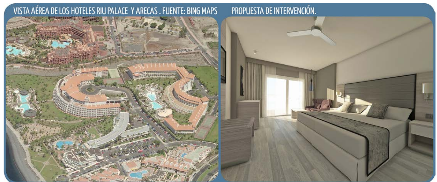
Foto Izquierda: Estado actual. Foto Derecha: Propuesta intervención
