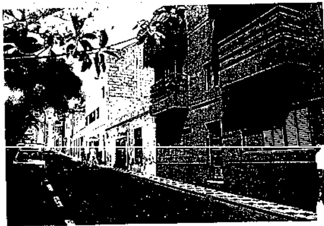
Figura Nº. 4-72.- CARRETERA PUNTA BRAVA.
