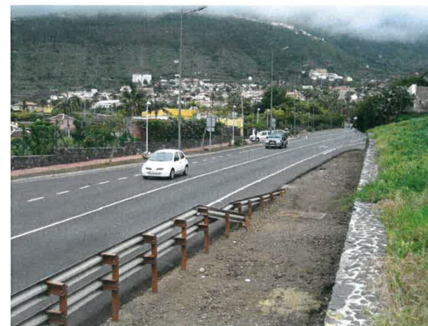
Actual carretera TF-31 (la zona de tierra corresponde al futuro Ramal de incorporación a la TF-31)
