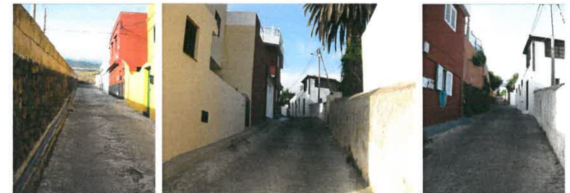
Edificaciones de uso residencial existentes en el ámbito del sector
