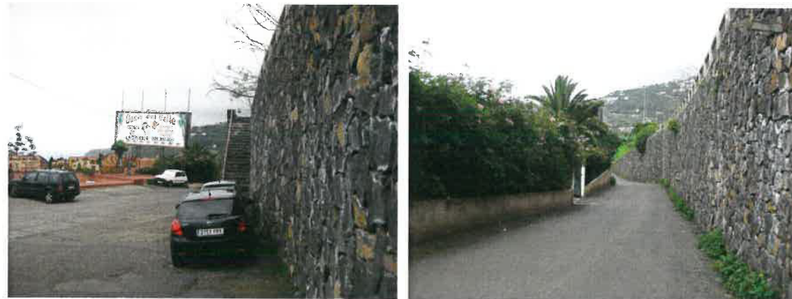
Desnivel desde la Autopista a la zona de "Oasis del Valle"
