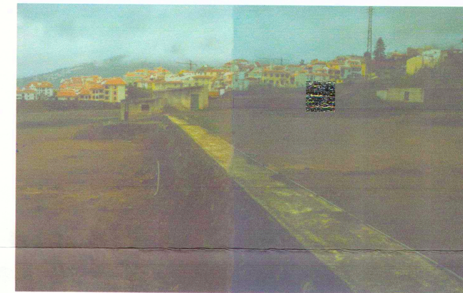
Foto n°3: Podemos observar en la foto una de las muchas construcciones en fase de deterioro asociadas a los usos agrícolas desarrollados en el pasado. También dichos terrenos presentan redes de conducción hidráulica en fase de deterioro (atarjea) que deberán ser desmanteladas y donde los residuos generados deberán ser transportados a vertedero autorizado.
