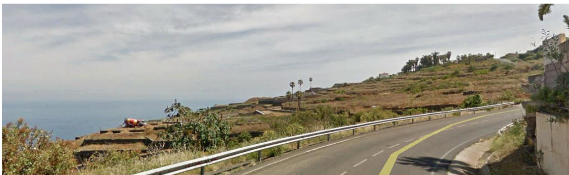
Vista de las parcelas del extremo sur del ámbito desde la Vía de Servicio adyacente a la TF-5.
