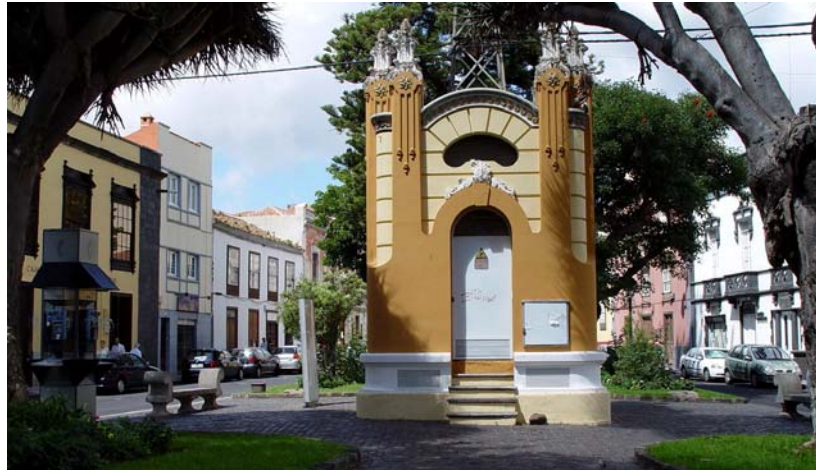
Torreones de Transformación Eléctrica
