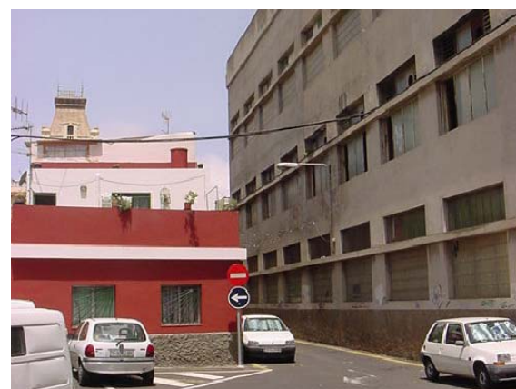
3 EDIFICIOS DE DIFERENTES ALTURA
