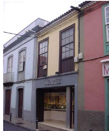
EJEMPLO 2 - ESTADO ACTUAL
