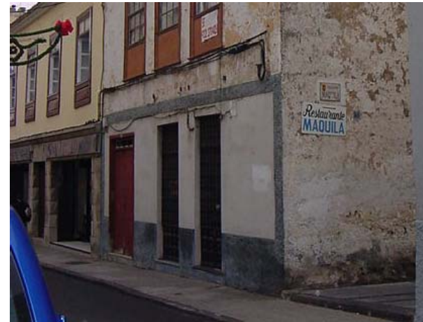
EJEMPLO 3 - ESTADO ACTUAL
