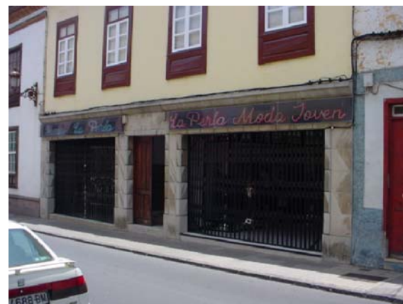
2 PÉRDIDA DE TIPOLOGÍA EN PLANTA BAJA
