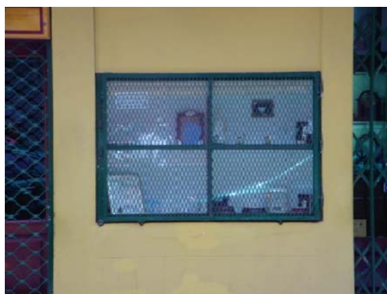
4 VITRINAS INADECUADAS EN LOS MUROS
