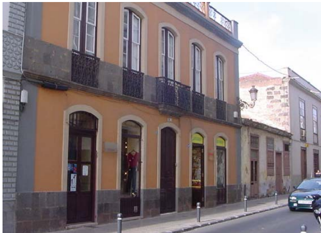
EJEMPLO 1 - ESTADO ACTUAL
