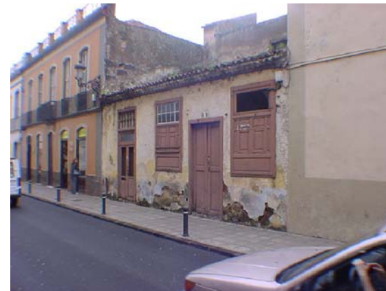
3 MEDIANERAS EXPUESTAS POR DIFERENCIA DE ALTURA
