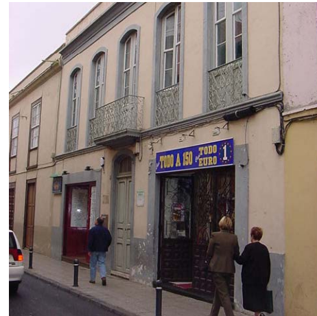
EJEMPLO 3 - ESTADO ACTUAL
