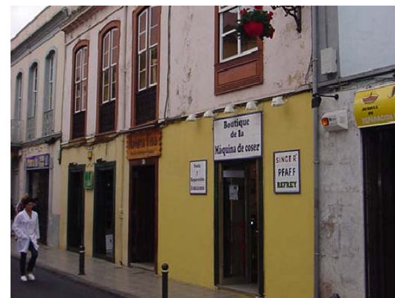
6 EXCESO DE RÓTULOS
