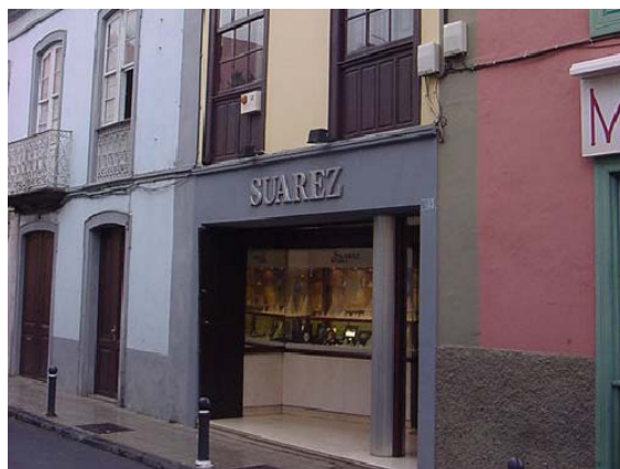
4 PÉRDIDA DE TIPOLOGÍA EN PLANTA BAJA
