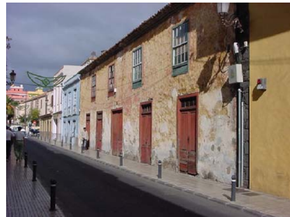
2 REVESTIMIENTOS DETERIORADOS
