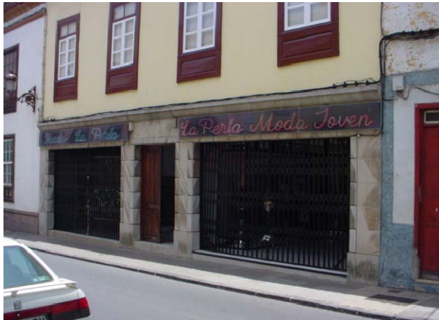
EJEMPLO 1 - ESTADO ACTUAL
