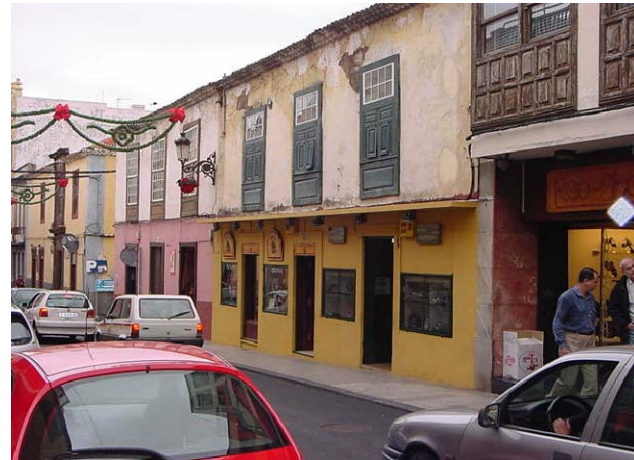
EJEMPLO 2 - ESTADO ACTUAL
