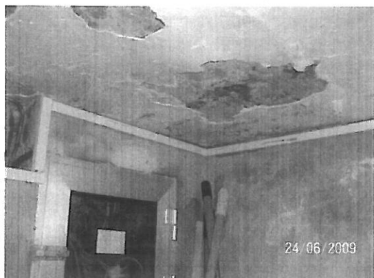
Foto: Vista parcial techo cuarto
