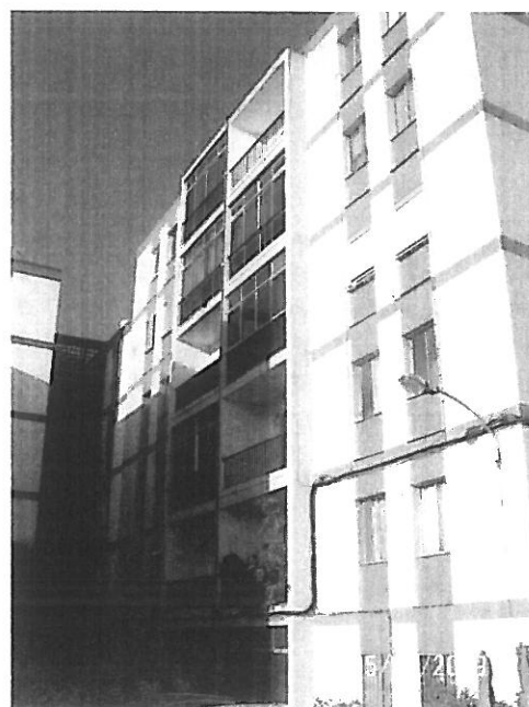
Foto: Vista fachada trasera
