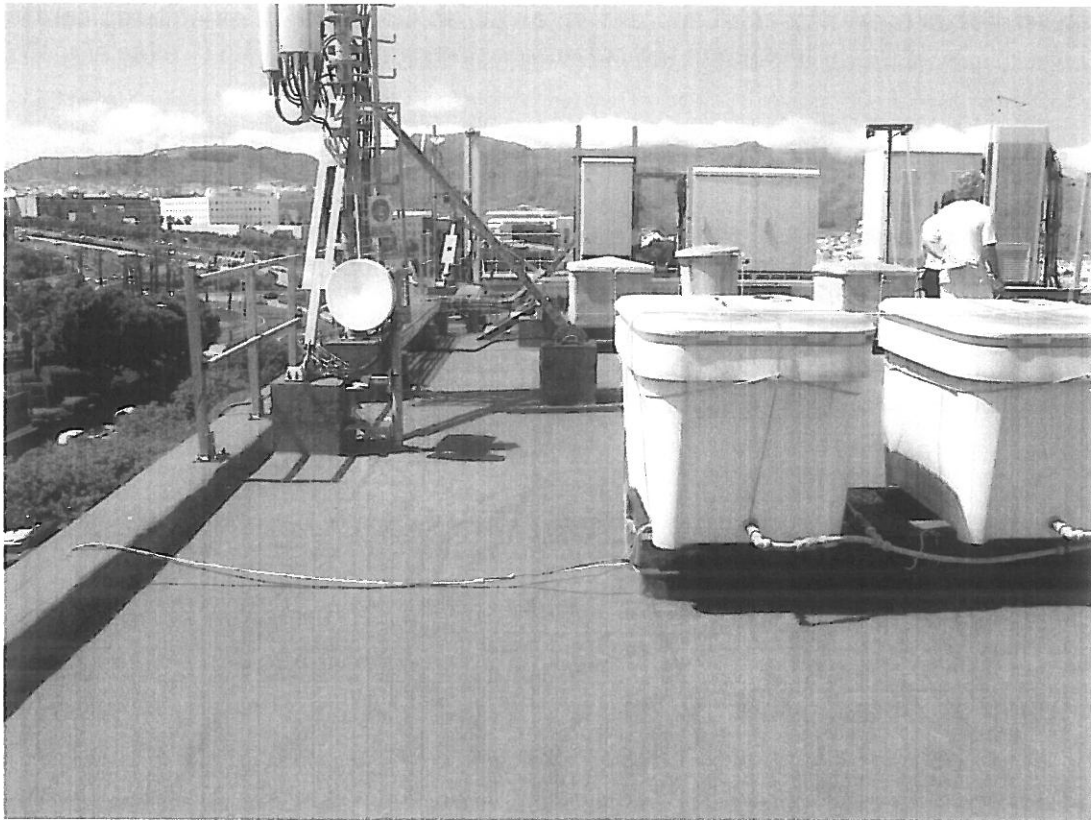
Foto: Vista cubierta bloque delantero.
