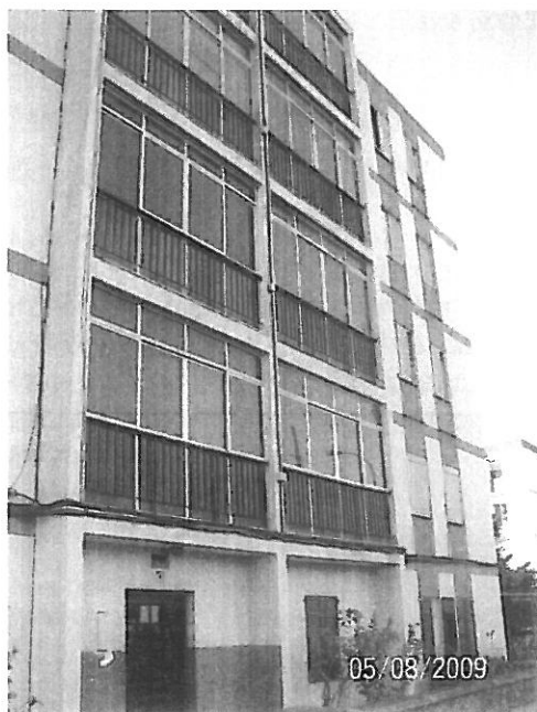
Foto: Vista fachada delantera
