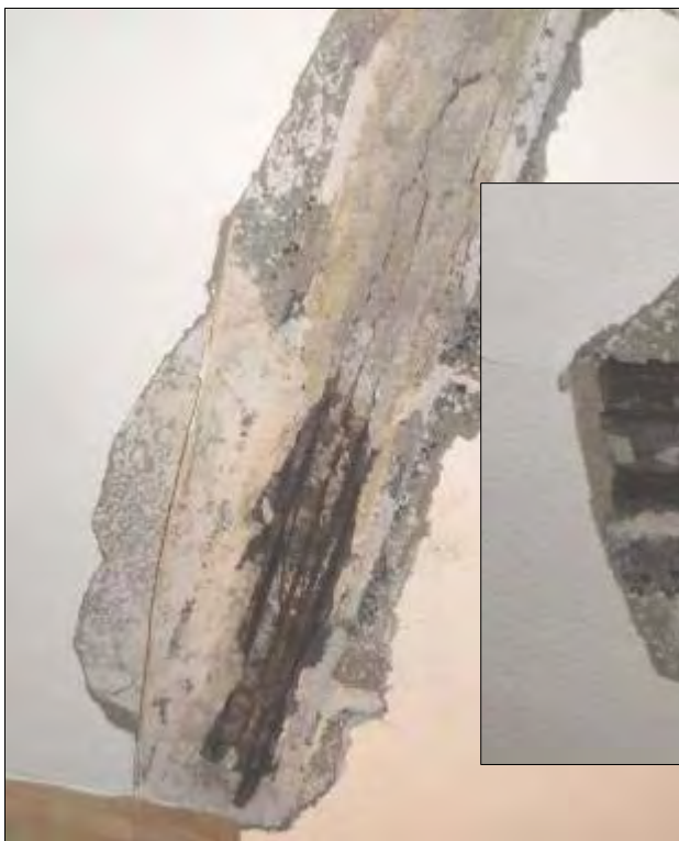
Ejemplos de corrosión avanzada de los alambres, incluso roturas de alambres Figura nº 7
