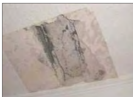
Ejemplos de corrosión de los alambres en las viguetas en las que hemos realizado calas Figura nº 6
