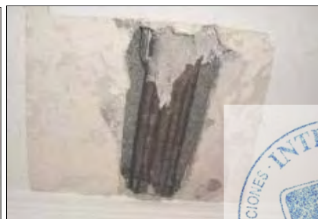
Ejemplos de corrosión de los alambres en las viguetas en las que hemos realizado calas Figura nº 6
