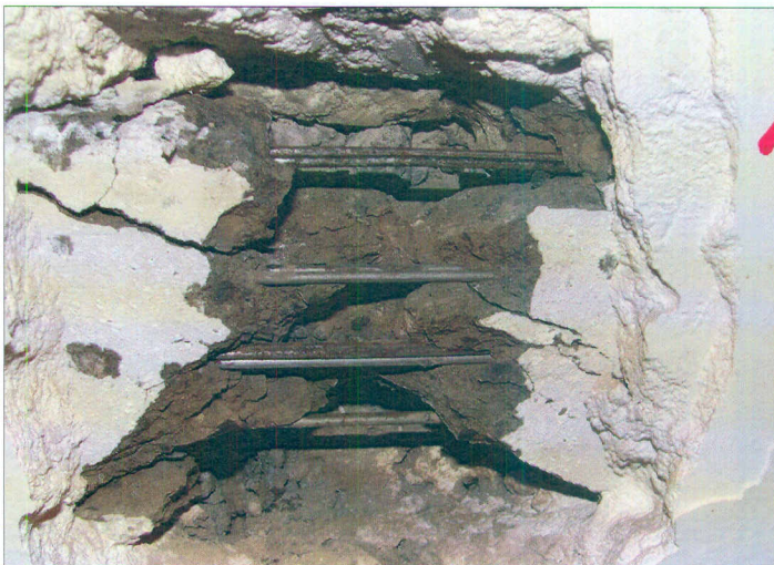
Véase la coloración marrón oscura del hormigón de la vigueta
