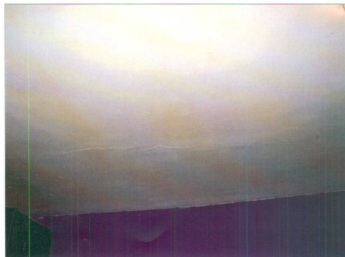
Figuras en acabados de techo marcando la posición de las viguetas
