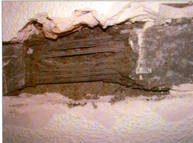
Vista de una cala realizada en zona no húmeda
