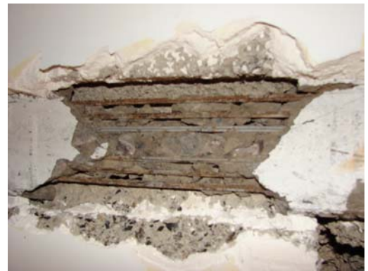
Vista de la cala realizada. Buen estado de los alambres.
