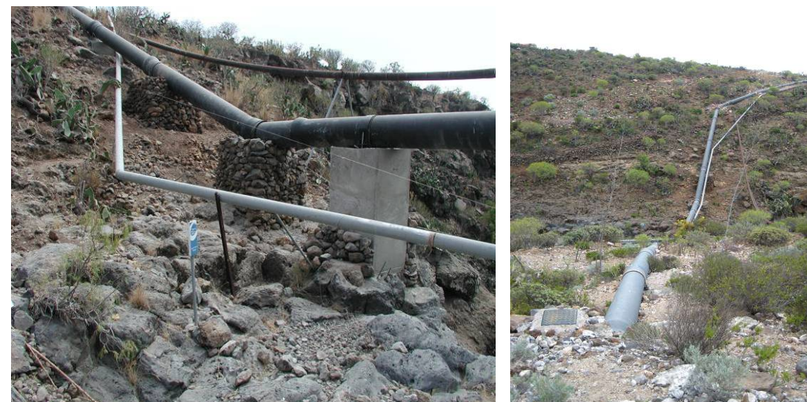
Ancho de banda y vistas generales de la tubería de fundición que atraviesa el ámbito
