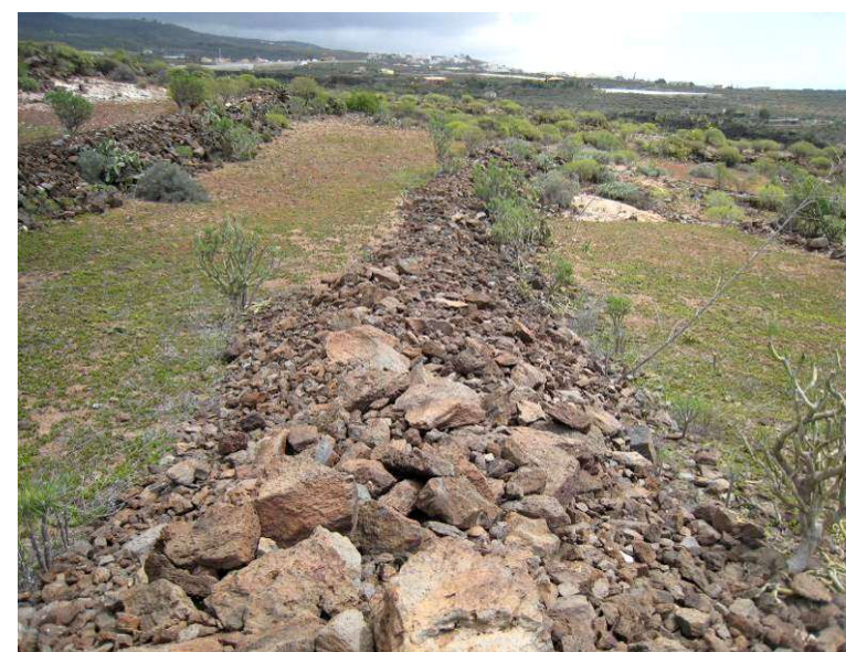
Derrumbe de muros de bancales abandonados
