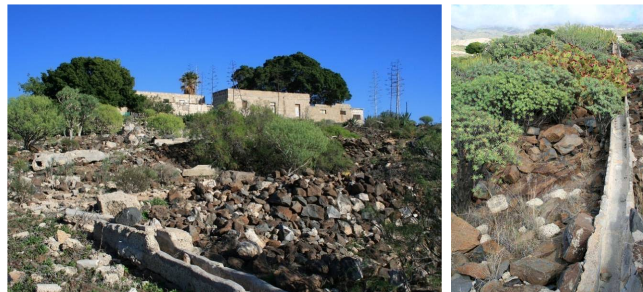
Edificaciones e infraestructuras de riego abandonadas y en desuso existentes en el ámbito del sector
