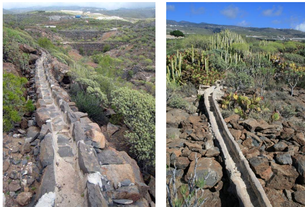
Infraestructuras de riego tradicionales (tarjeas) existentes en el sector actualmente en desuso
