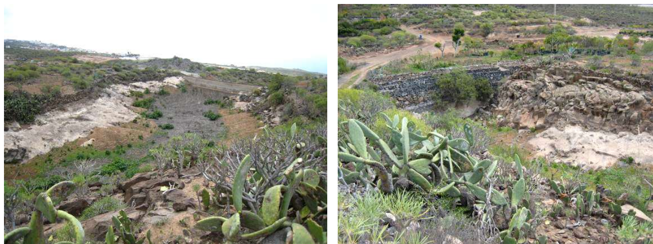
Vistas generales de una presa situada a la cota 370 m
