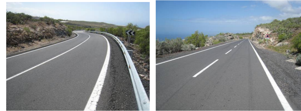
Vistas generales de la carretera TF-465 a su paso por el Sector de Maguenes
