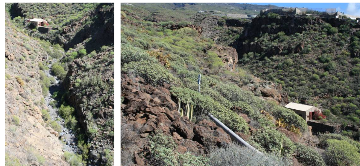
Vistas generales del pozo situado en el cauce del Barranco de Erques
