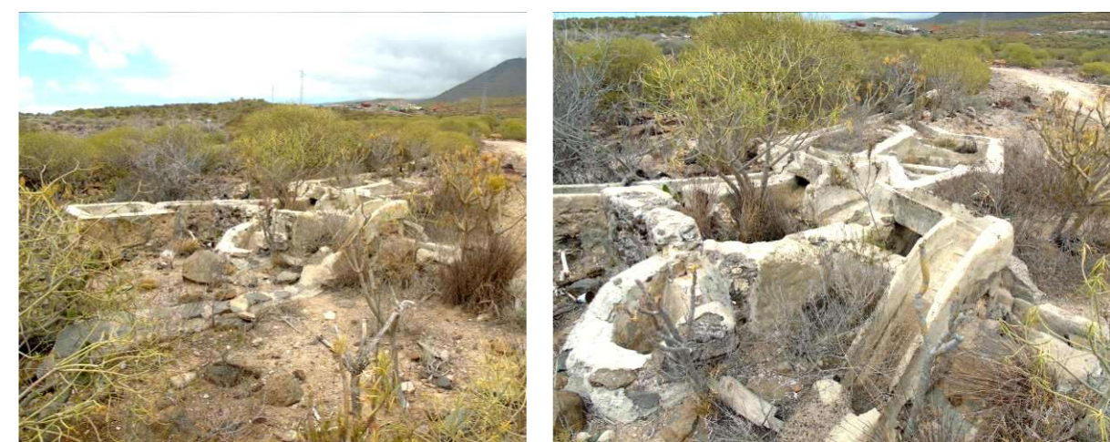
Vistas de la red de riego abandonada y a conservar
