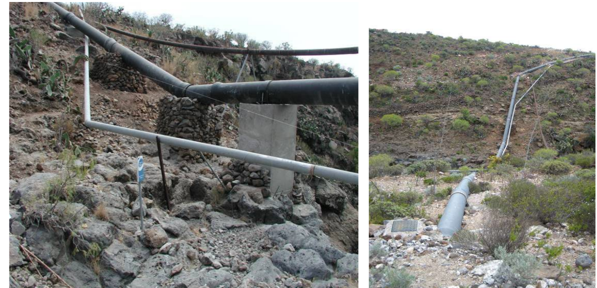
Ancho de banda y vistas generales de la tubería de fundición que atraviesa el ámbito
