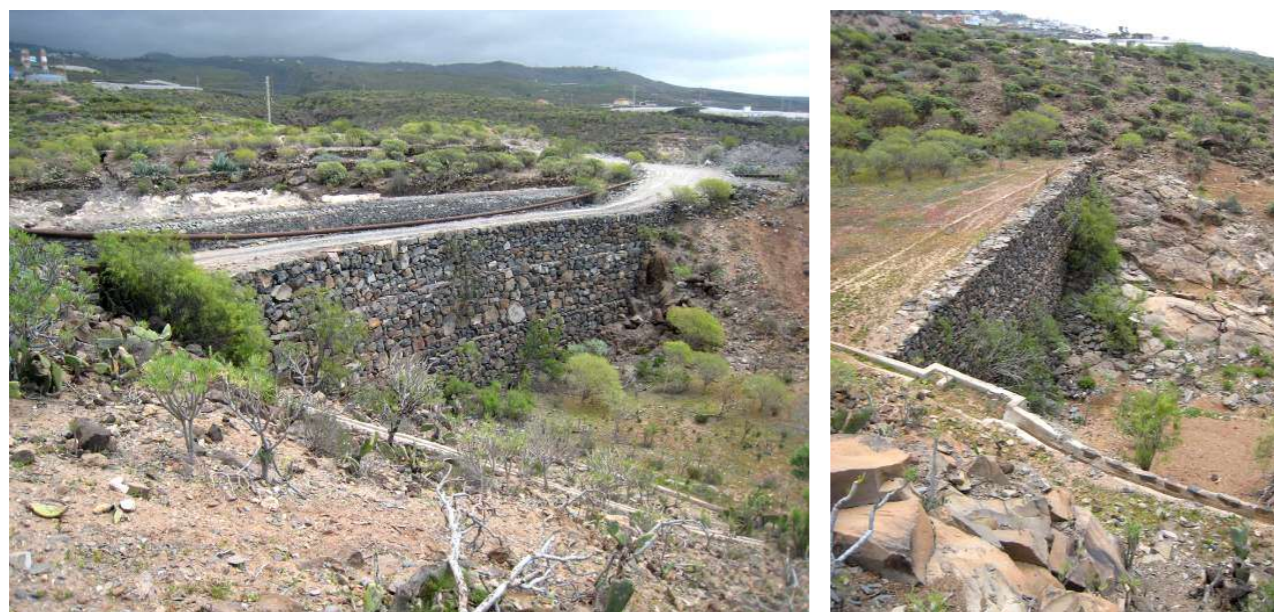
Vistas generales de los muros – presa de mampostería basáltica
