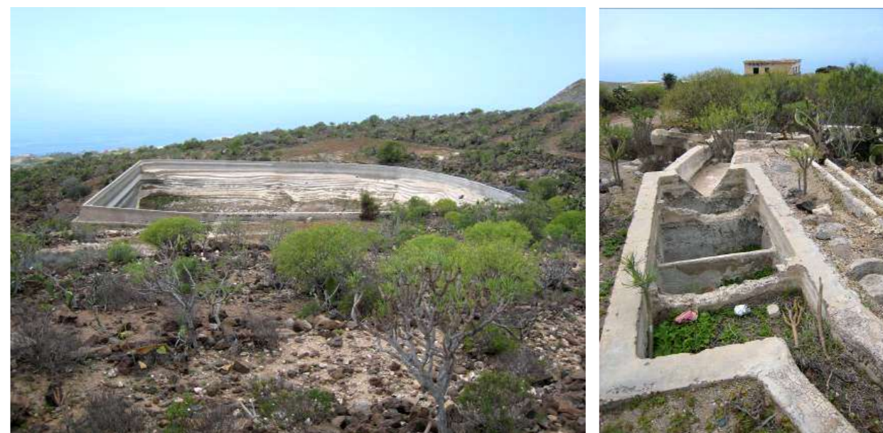
Vistas de parte de la red de riego asociada a las explotaciones agrícolas abandonadas
