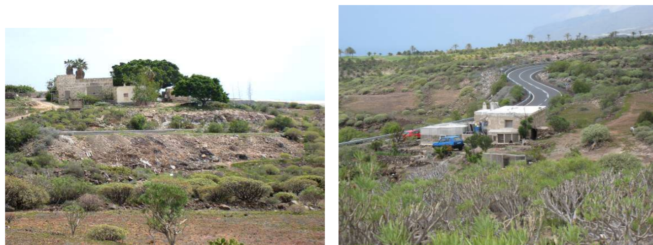
Vistas de edificaciones existentes en el ámbito de estudio
