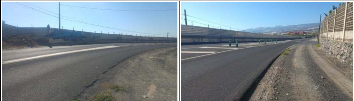
Punto de visualización 2: carretera TF-47 a la altura del sector.
