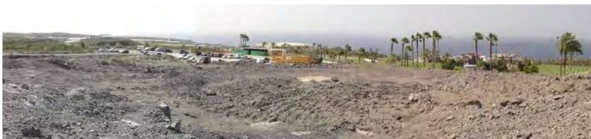
Zonas de aparcamiento (al fondo) y áreas de vertido y extendido de RCDs (en primer plano).
