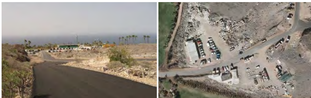
Zona de aparcamiento. Materiales y maquinaria de obra.
