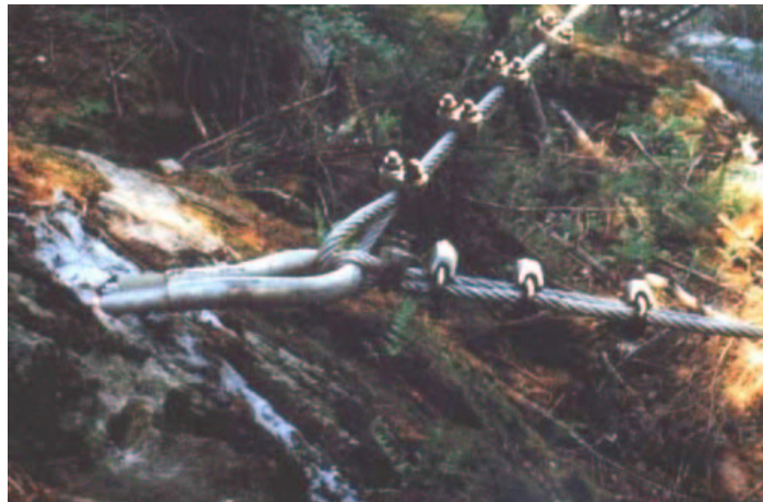
Foto 3.2.2.3.- Detalle de anclaje. (Fuente: GEOBRUGG).
