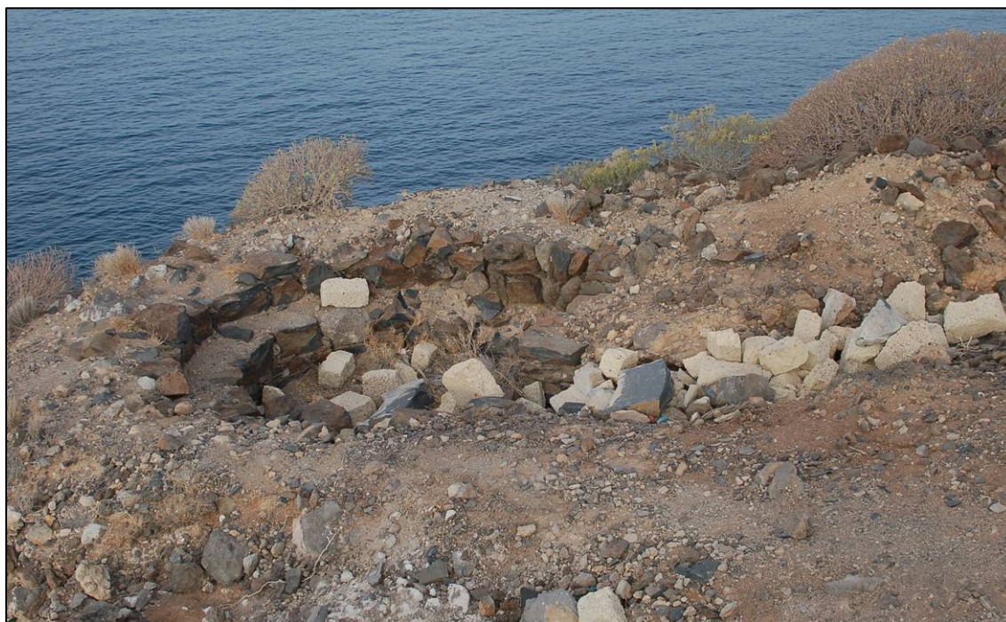
Imagen general en el que se observa como una parte de la estructura se encuentra sepultada por escombros generados por la realización del paseo litoral por el acantilado.
