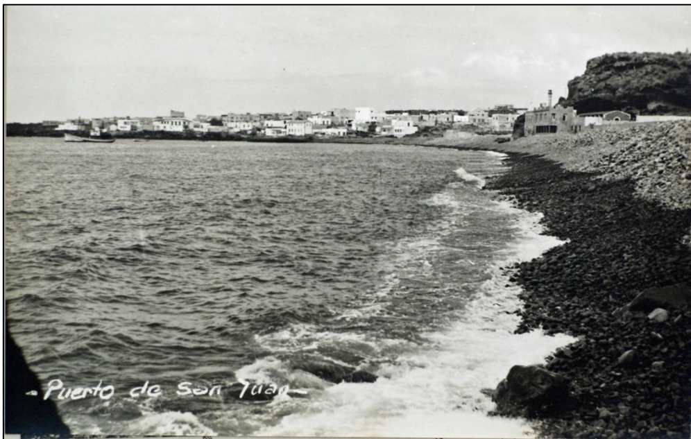
Vista general desde el final de la playa del asentamiento de Playa de San Juan. En primer término se aprecia la fábrica de pescado. Al fondo, la
