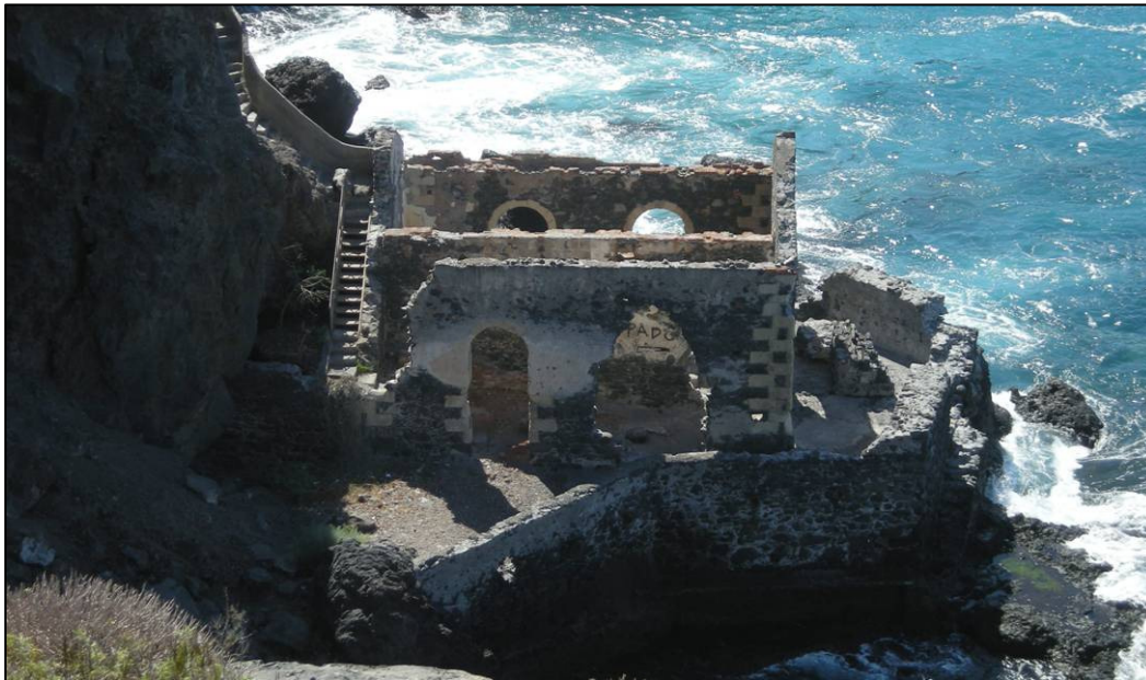
Imagen del antiguo embarcadero que posiblemente fuese utilizado para dar salida a la producción agrícola de la zona. Hoy se encuentra en estado ruinoso.
