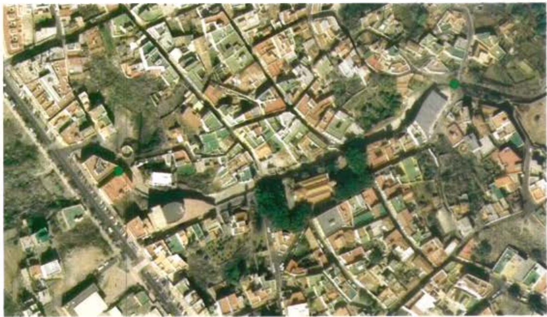
Vista del tramo canalizado
