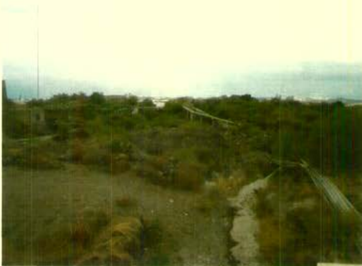
Escombros al final de la canalización
