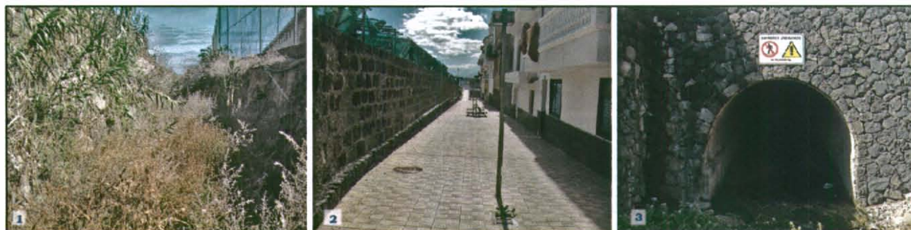
Imagen 9. Tres instantáneas del riesgo de inundación y aluvionamiento del barranco de Correa: 1. Una sección del cauce ocupada por la vegetación; 2. Un tramo del cauce archetado a través del suelo urbano de Caleta de Interián; 3. Desembocadura del barranco en la playa, se observa además la salida de aguas negras.
