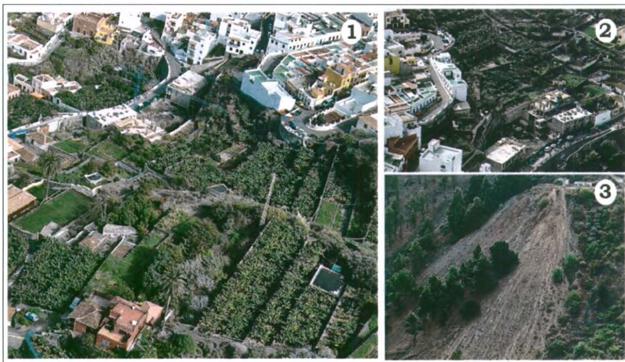
Imagen 11. El cauce del barranco del Reparó en las inmediaciones del casco de Garachico: 1. Vista aérea de la zona donde se ha realizado el perfil; 2. Una perspectiva de la misma zona en la que se aprecia como el callejero y lo edificado atraviesan el cauce del barranco, 3. Entullera situada en la parte alta del acantilado que en caso de movilización inundaría el cauce bajo del barranco.
