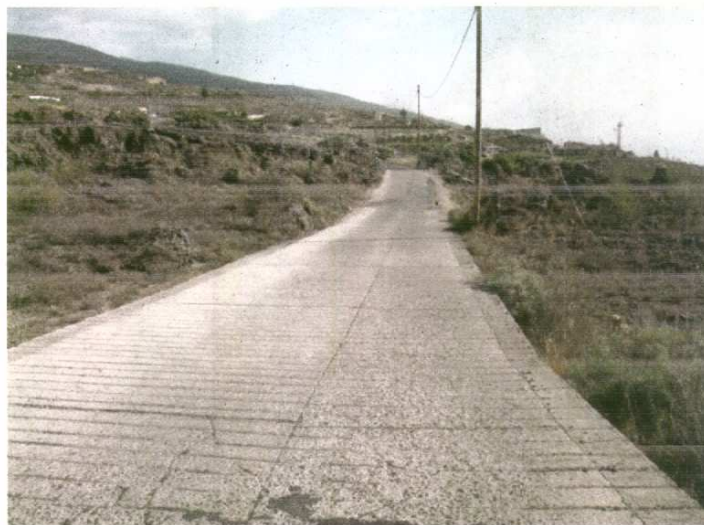
Imagen de la Pista cruzando el cauce.
