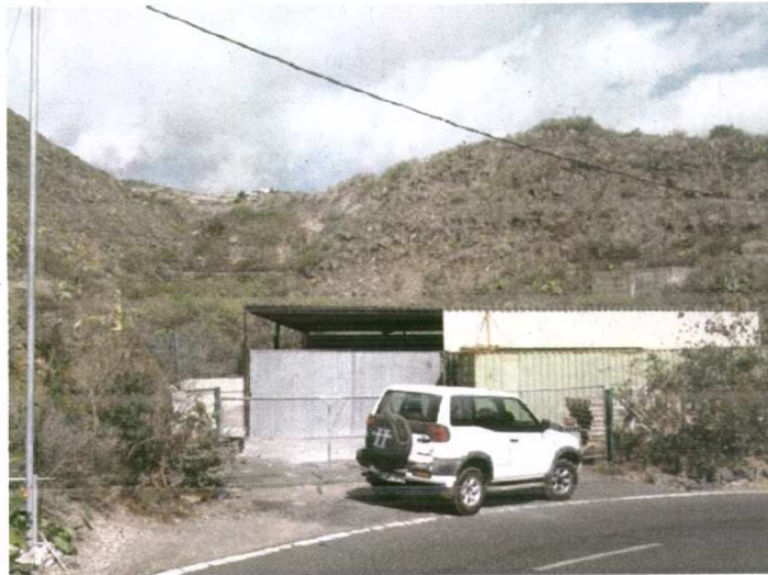
Imagen del almacén que obstruye el cauce
