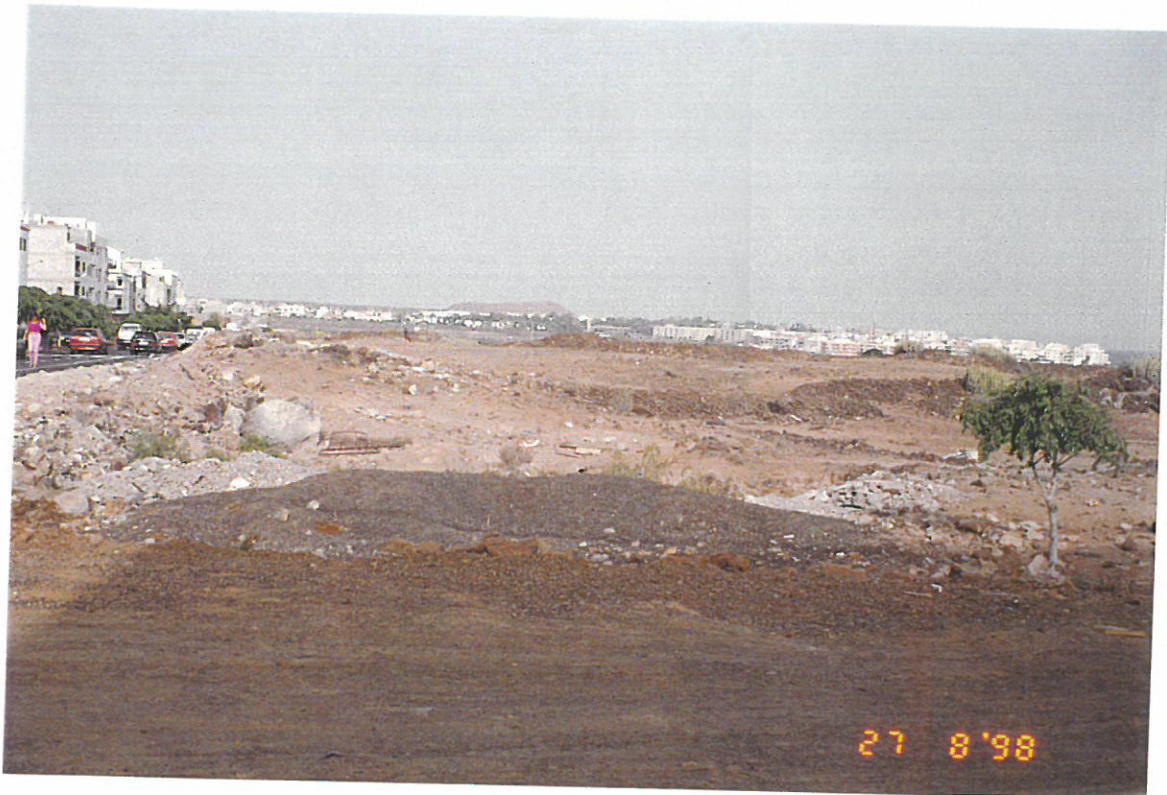
FOTO-14, VISTA HACIA LAS GALLETAS Y CALLE FUERTEVENTURA
