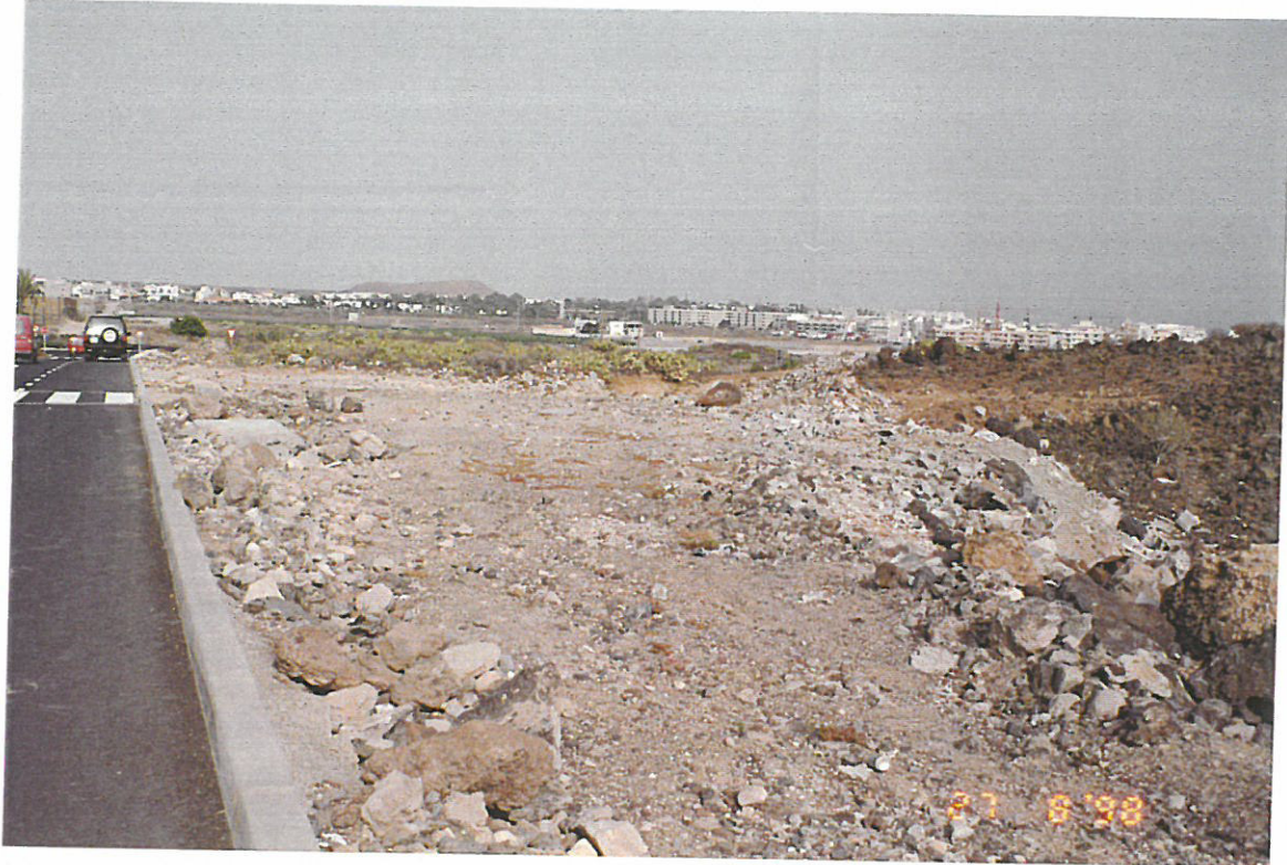
FOTO-13, VISTA HACIA LAS GALLETAS Y CALLE FUERTEVENTURA
