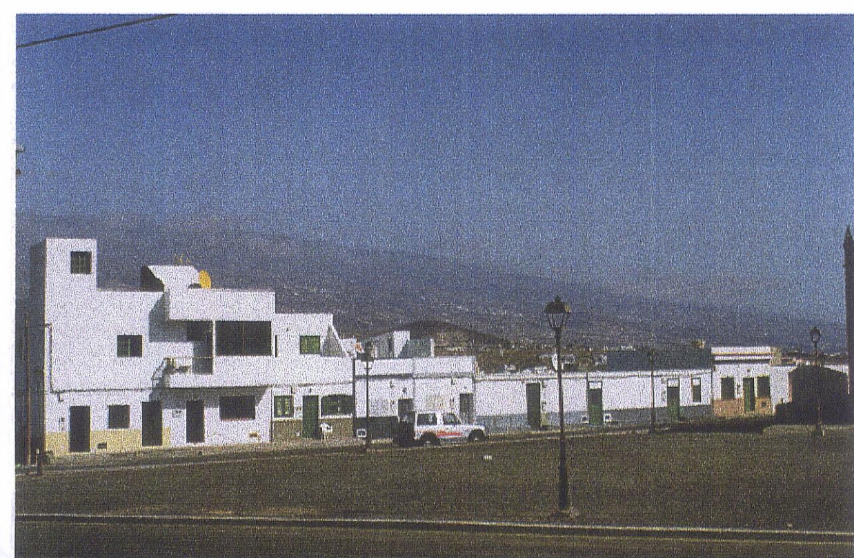
Vista de la Fachada de la Manzanilla M2.
