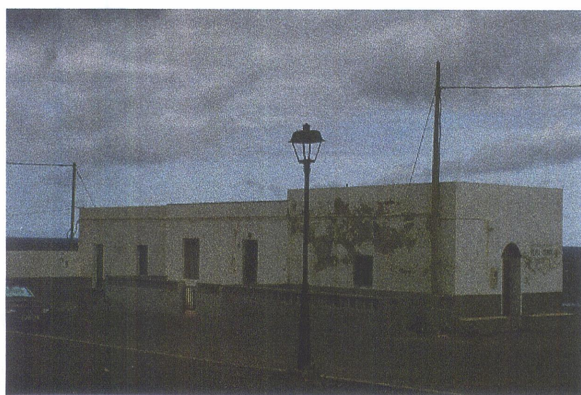
Fachada de la Manzanilla S1.
