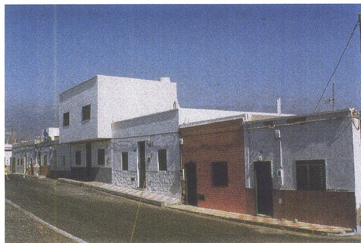
Vista de la Fachada de la Manzanilla M3.
