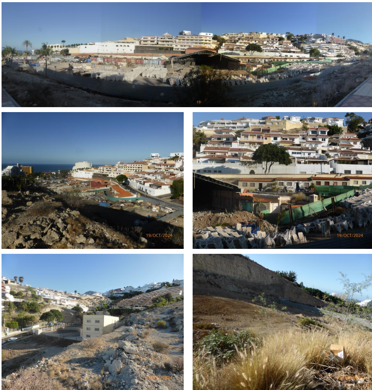
Fig.7 Estado actual del ámbito de desarrollo de la MM (acopios de materiales, uso residencial fuera de ordenación, infraestructuras en estado ruinoso, edificaciones, etc.).
