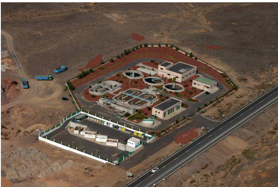
Depuradora y Punto Limpio de Playa Blanca
