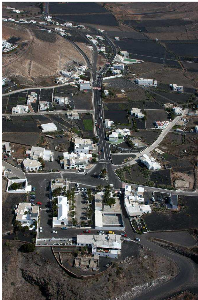
Vista general del núcleo de Femés desde el sur
