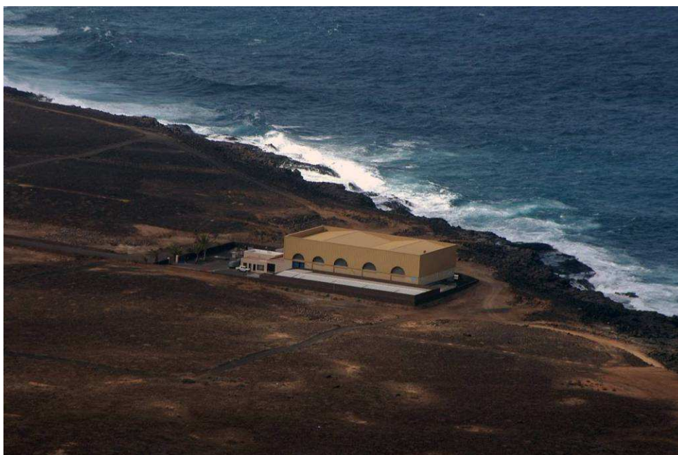
Desaladora de Janubio
