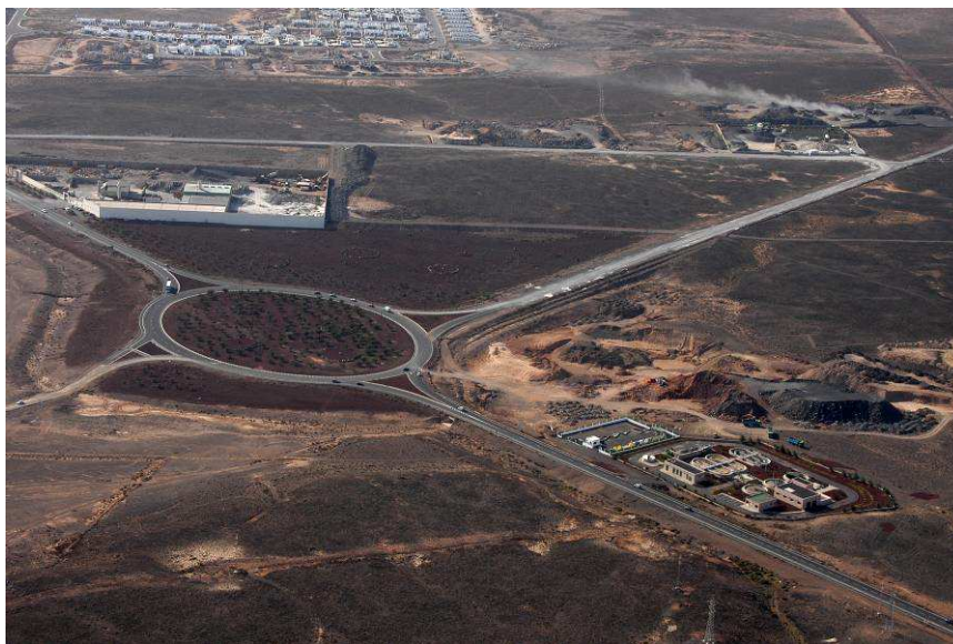
Estación Depuradora de Playa Blanca
