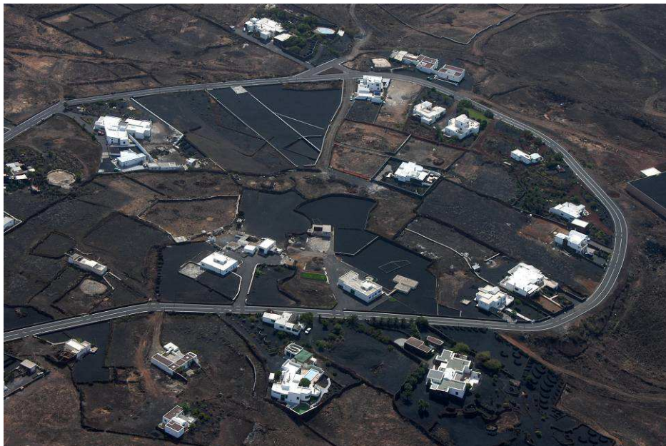
Vista de ámbito sur del asentamiento rural de Las Breñas
