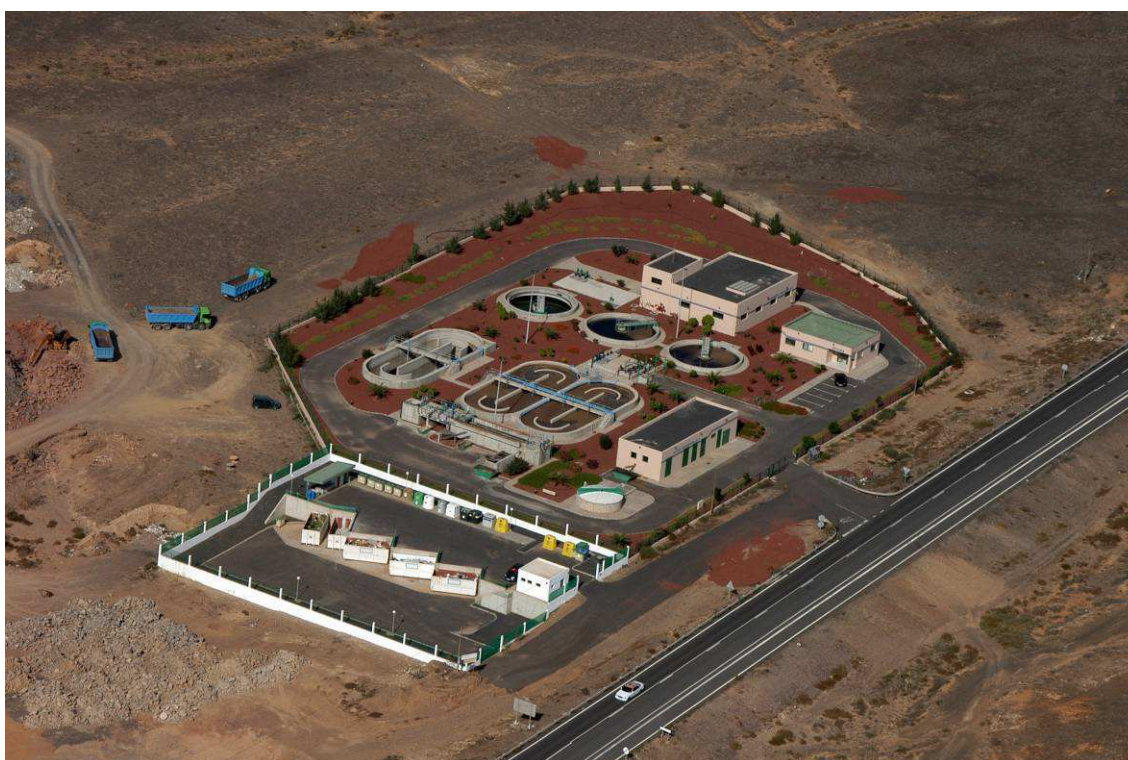
DEPURADORA Y PUNTO LIMPIO DE PLAYA BLANCA
