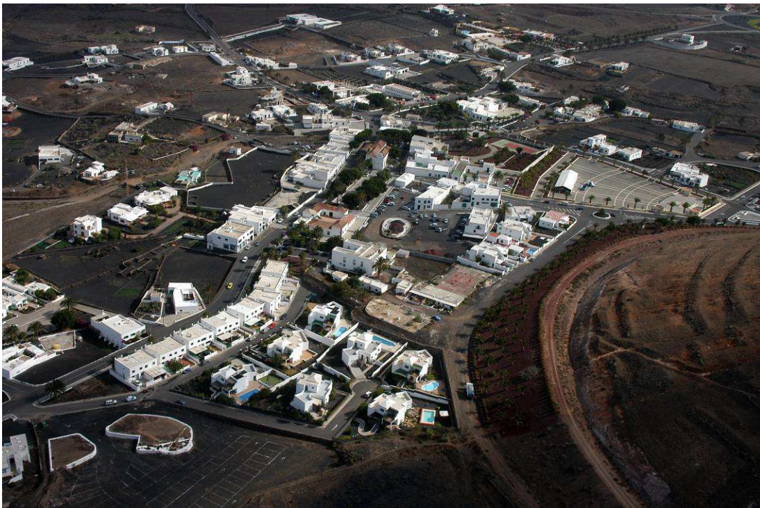
VISTA DEL CENTRO DE YAIZA
