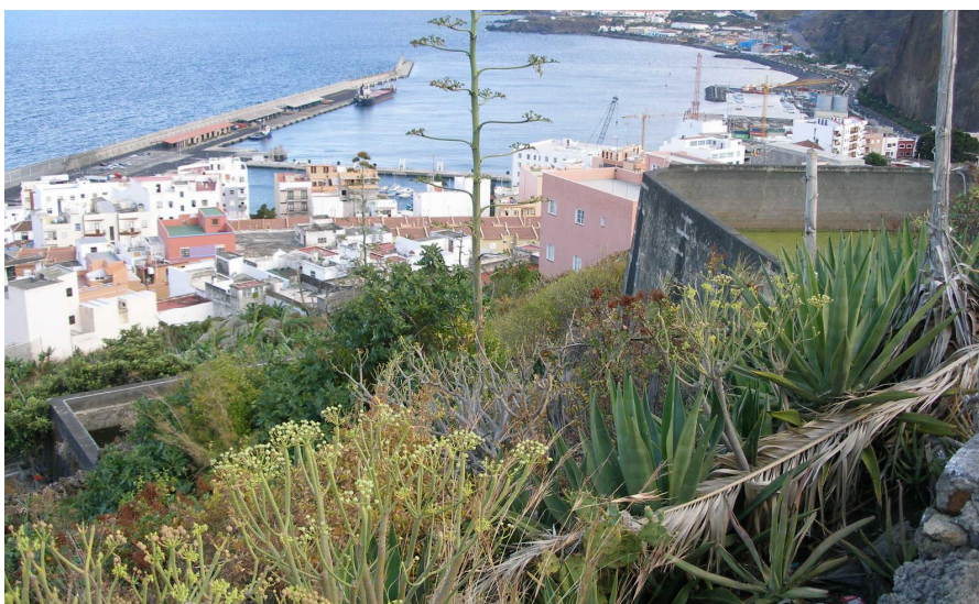
Un cultivo tan exigente como el del plátano requiere necesariamente la existencia de infraestructuras que garanticen el abastecimiento y su riego.
