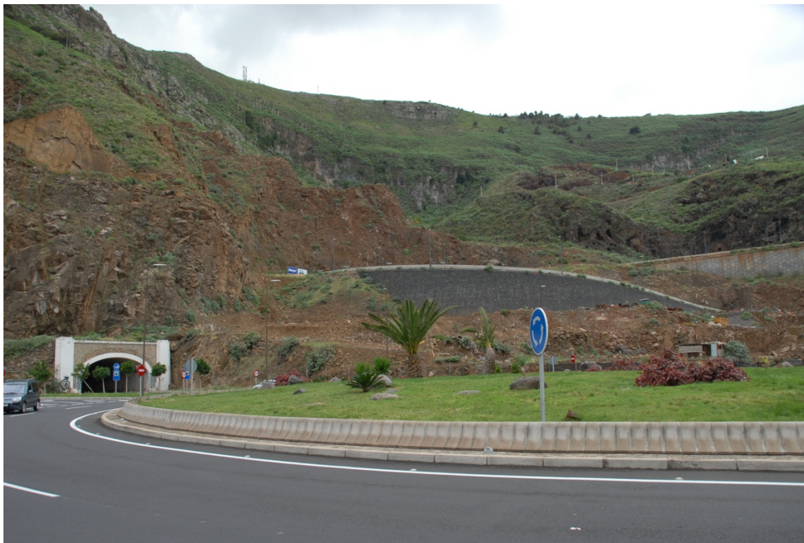
Comienzo de la Vía exterior en la rotonda de conexión con la carretera LP-1 y el túnel de Bajamar
