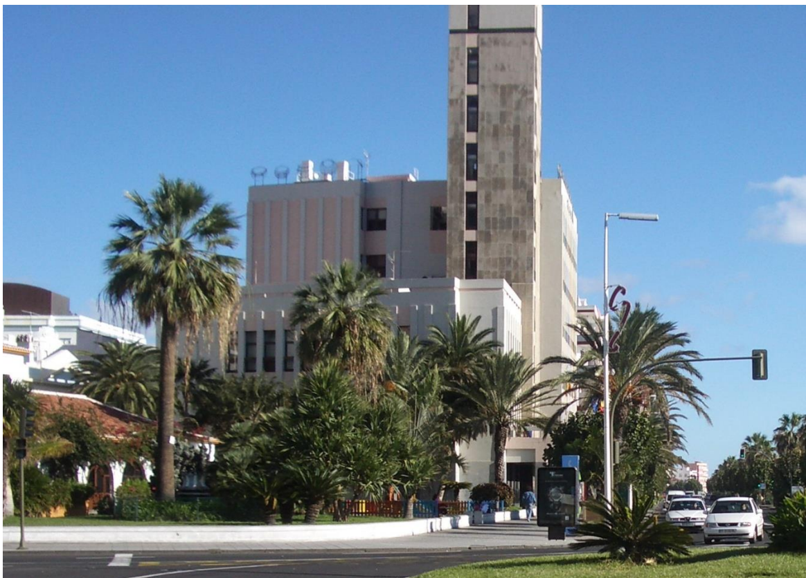
Vista parcial del ámbito de actuación
