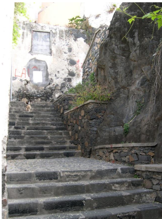
Vista parcial del callejón El Reloj
