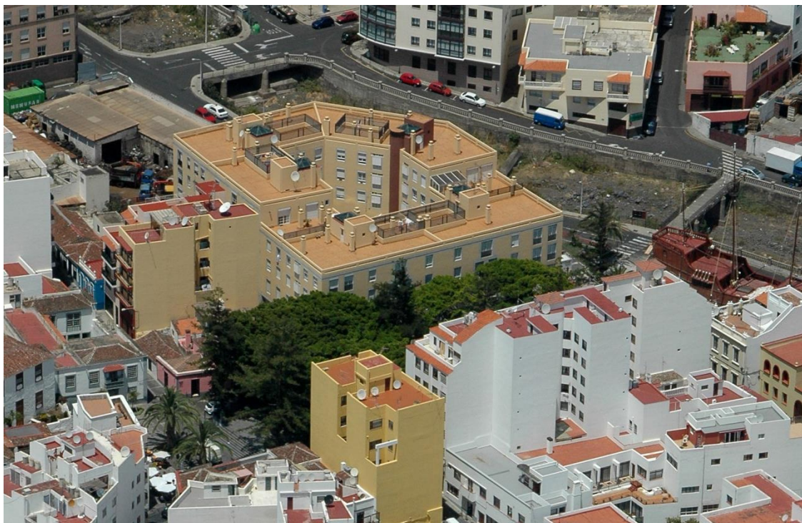
Vista aérea del ámbito de actuación
