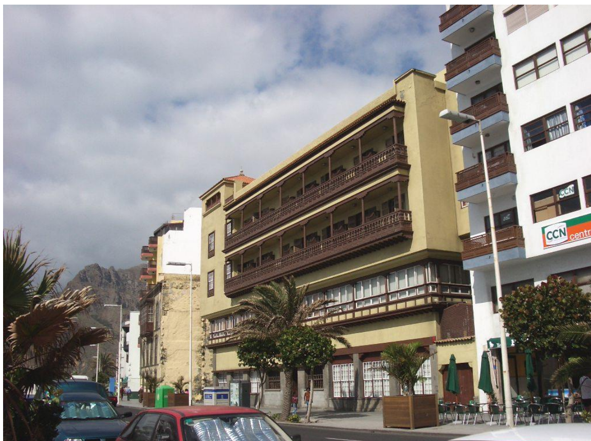
Vista general del antiguo Parador
