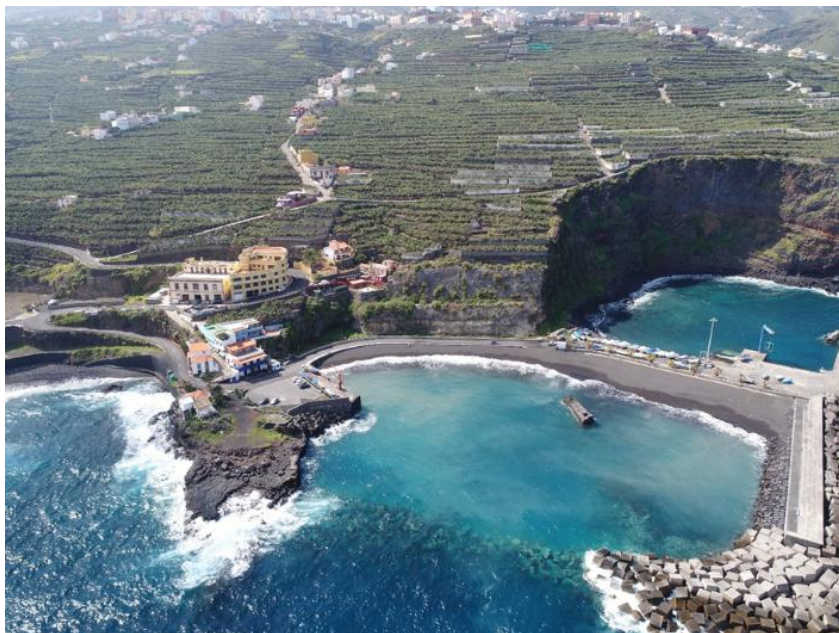
Vista aérea oblicua desde el este de la playa de Puerto Espíndola, observándose el deterioro de la escollera de protección de esta que provoca la desestabilización de la zona de arena.
