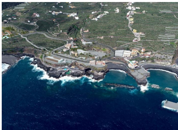
Imagen aérea de la Caleta de Rompecabos con la figuración del dique de protección emergente desde el Sureste.
