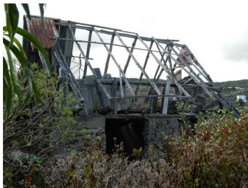
Armadura interna del techo.
