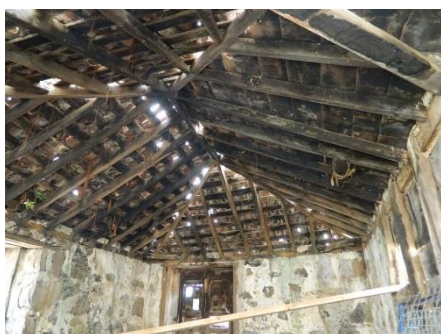
Vista interior de la estructura de la cubierta
