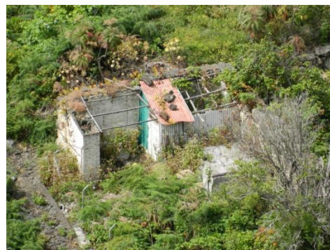
Vista general de la edificación.
