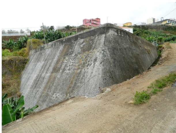
Vista General, donde se observa la pendiente del terreno.
