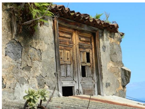
Detalle de ventana en fachada Sur
