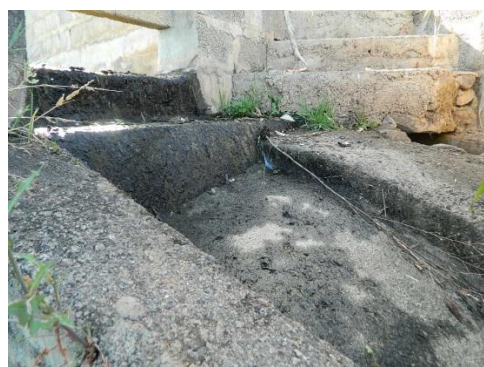
Salida de exedente de agua hacia el mar.
