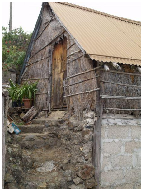
Vista acceso fachada Este
