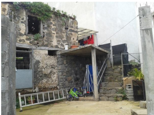
Vista de la zona anexa. Detalle de escalera de acceso a planta superior
