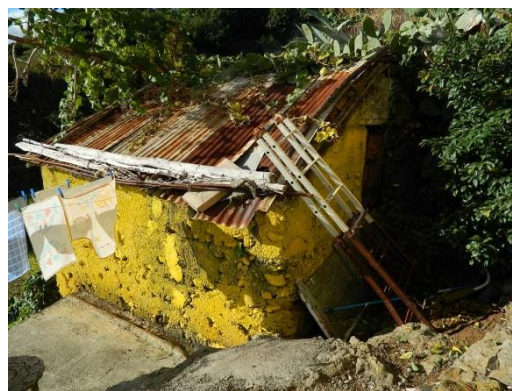
Vista trasera y cubierta
