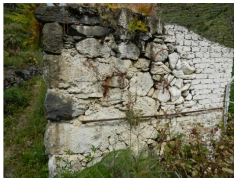
Detalle de esquina y pared este .
