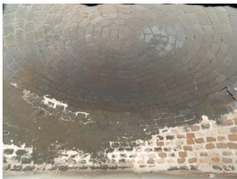
Detalle de la bóveda
