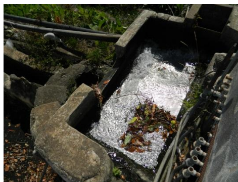
Detalle de la salida del reparto a través de tubería.
