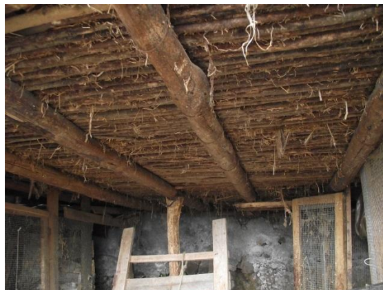
Vista interior techo planta baja
