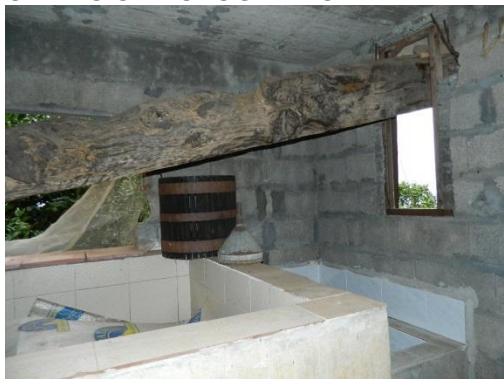
Vista interior de la viga del lagar y lagareto.
