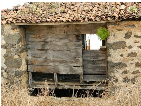
Detalle de hueco de entrada del grano y del agua.
