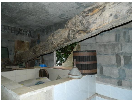
Vista interior del lagar y la viga de madera de tea de más de un siglo de antigüedad.
