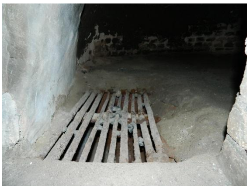
Detalle de rejilla de limpieza de cenizas. Abajo registro para controlar temperatura interior.
