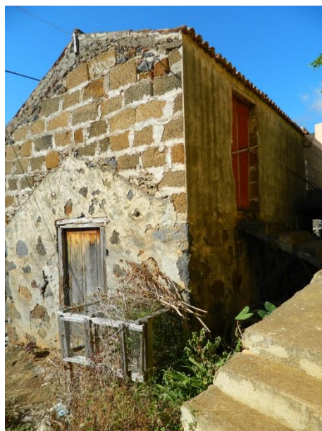
Fachada este y norte.
