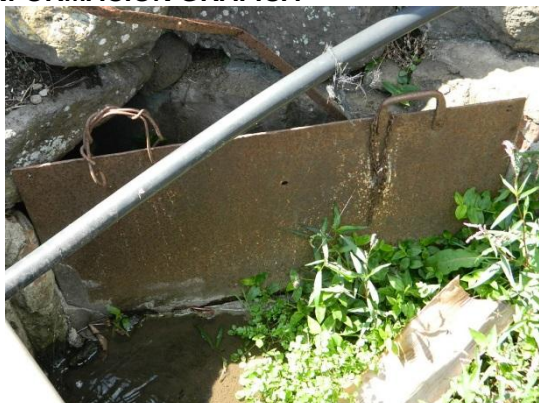
Detalle de torna de hierro
