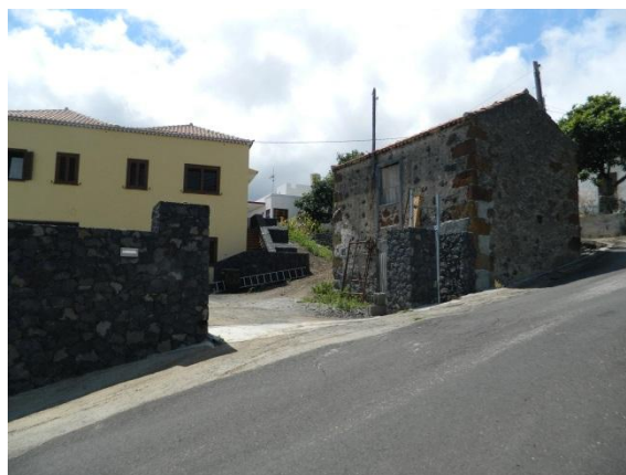
Fachada este y norte.
