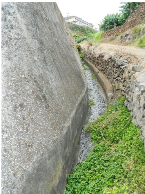
Atarjea adosada a la pared lateral norte
