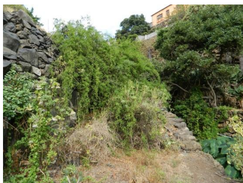
Vista general de situación
