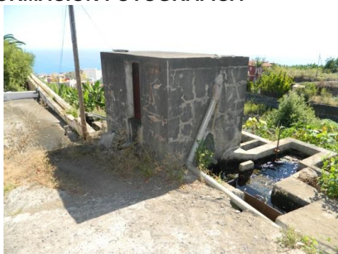
Vista del depósito repartidor de abasto junto a la repartidora de riego
