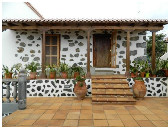
Vista de la edificación en la que inserta el elemento
