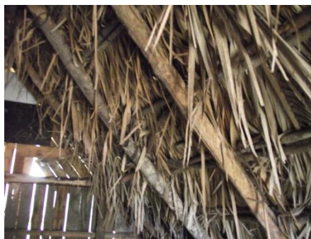
Vista interior techo.
