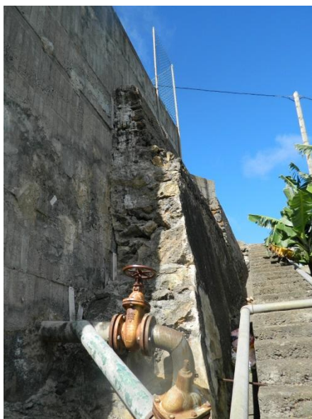
Detalle de tanquilla de distribución
