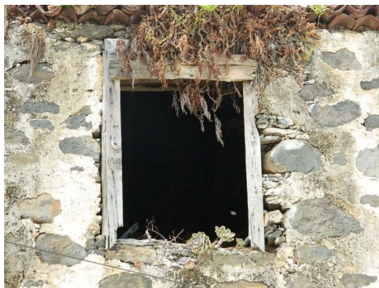
Vista de ventana de fachada Sureste
