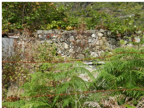
Detalle del interior de la pared oeste.
