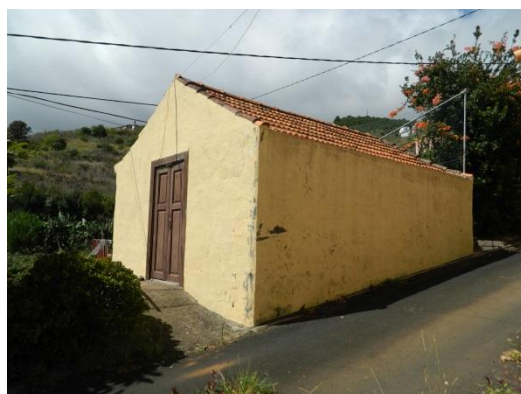
Fachada este y norte.
