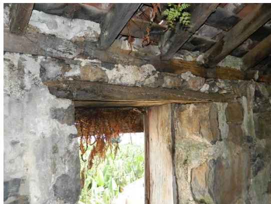
Detalle de dintel de ventana interior. Fachada Sureste
