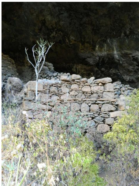
Fachada Sur del horno
