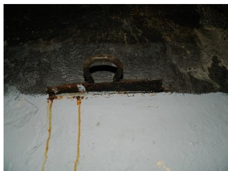
Detalle de rejilla de limpieza de cenizas. Abajo registro para controlar temperatura interior.
